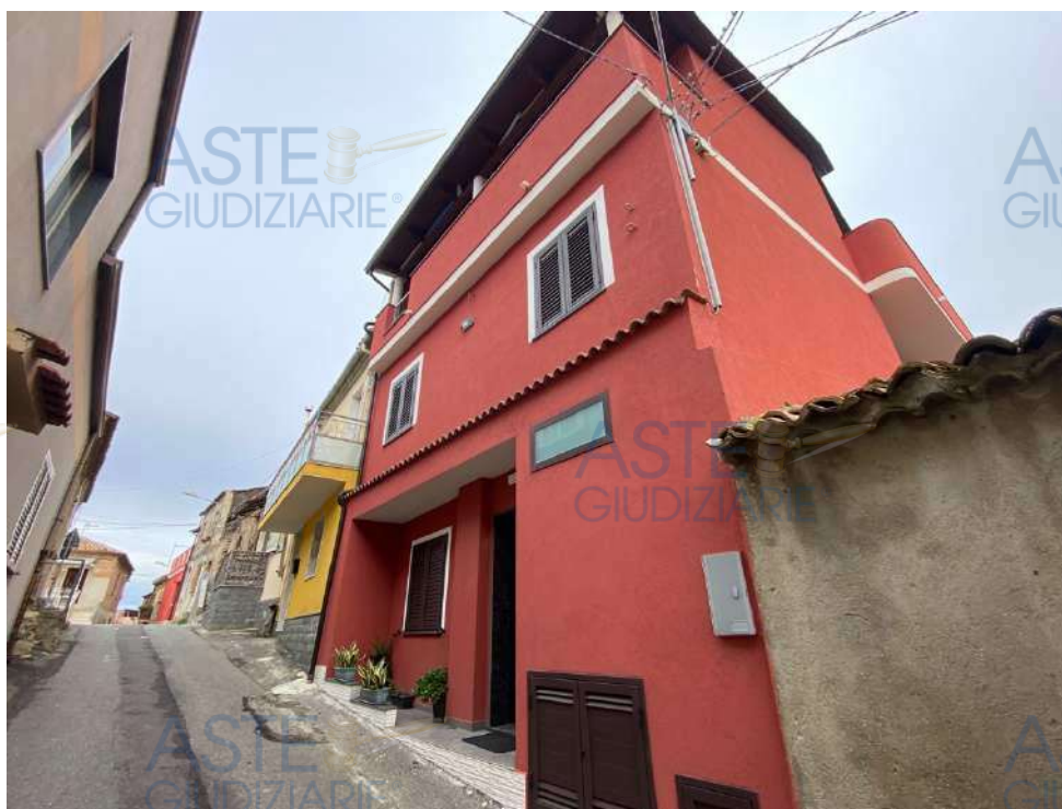
Figura 3 – Vista esterna dell'immobile oggetto di pignoramento.
