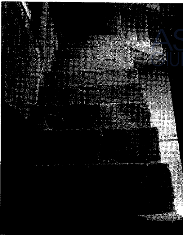
Foto n. 9 Scala acceso seminterrato
