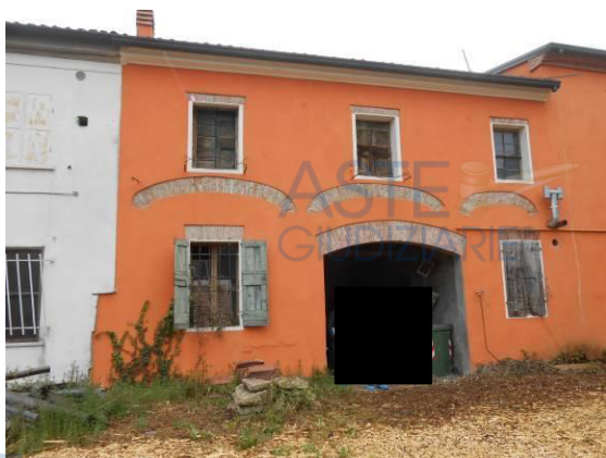
Foto della facciata che dà sulla corte interna
