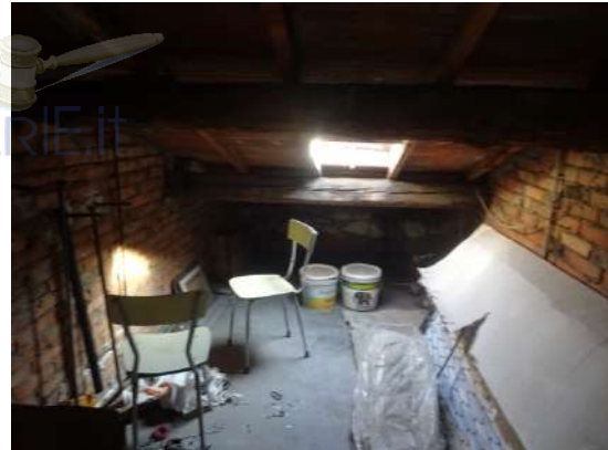
vista interno soffitta
