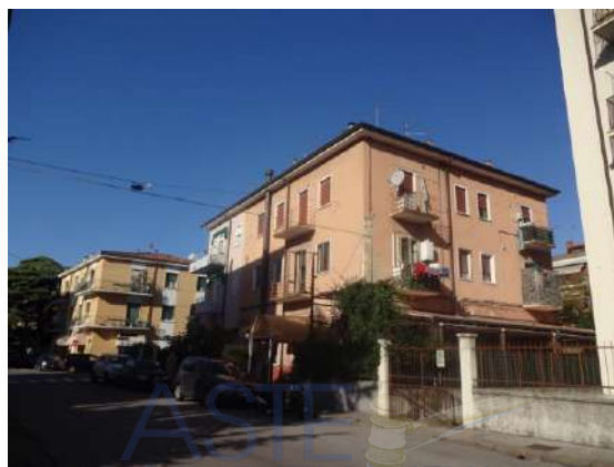
Facciata con esposizione ad est
