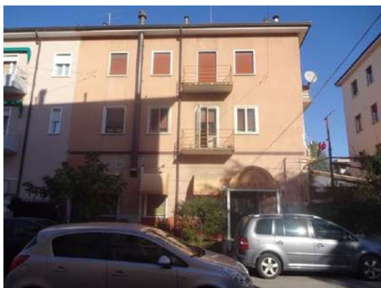
Facciata con affaccio su Viale Spolverini
