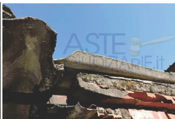
Foto 22 Lastre di copertura in cemento amianto
