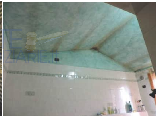
Foto 17 Soffitto del bagno con fenomeni di muffa
