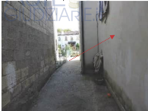
Foto 3 Vista fronte laterale
