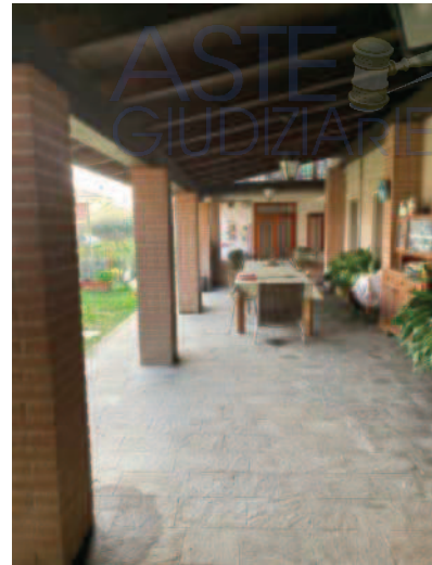
Portico lato nord
