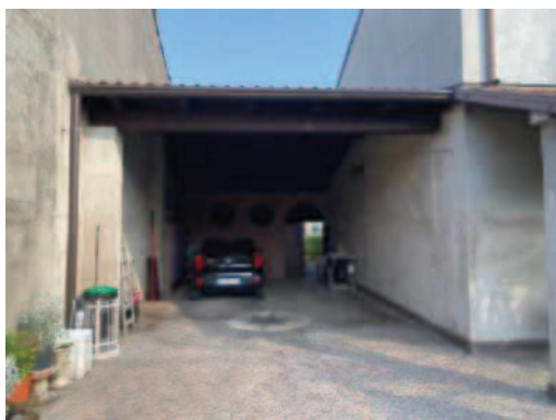
Portico lato ovest
