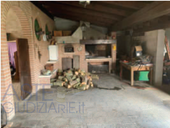
Portico lato nord
