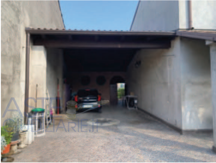
Portico lato ovest
