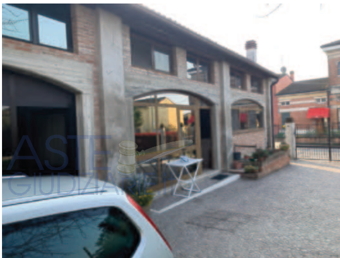
Vista esterna portico
