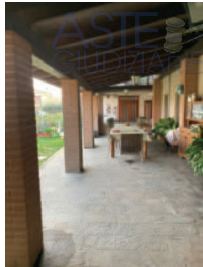
Portico lato nord
