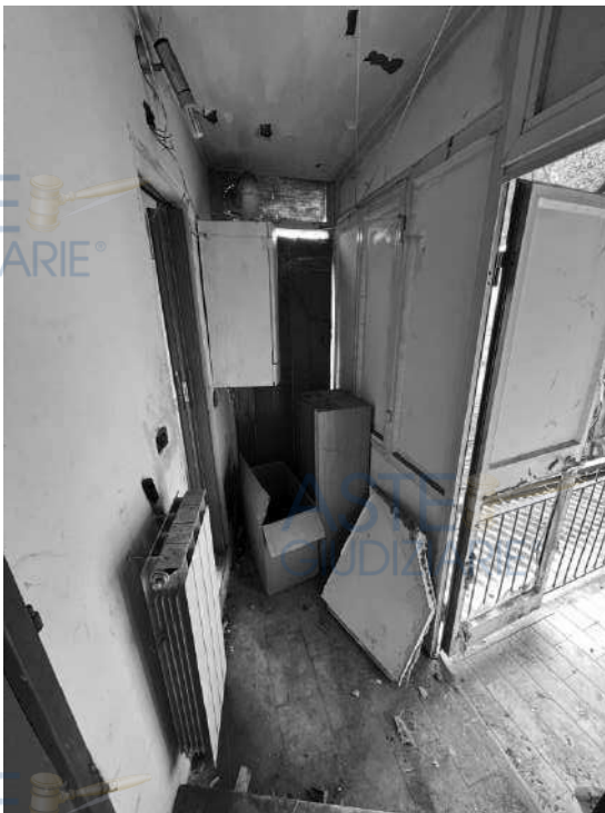
Vista del disimpegno
