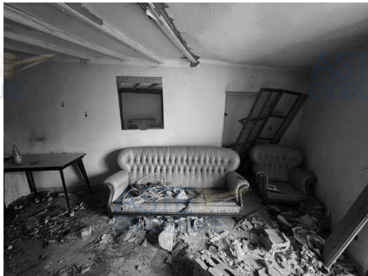
Vista del locale cucina - ingresso
