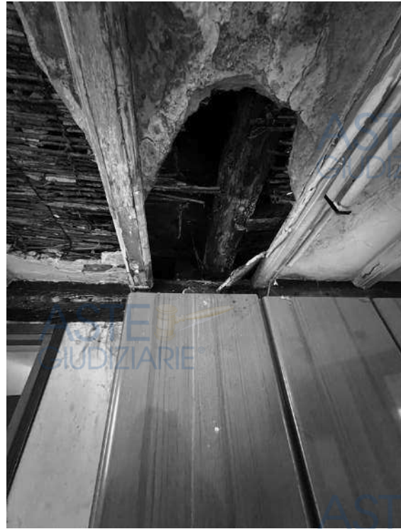
Vista del solaio
