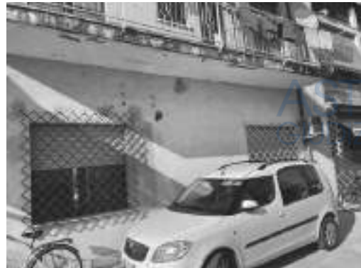
Prospetto sud sulla corte interna
