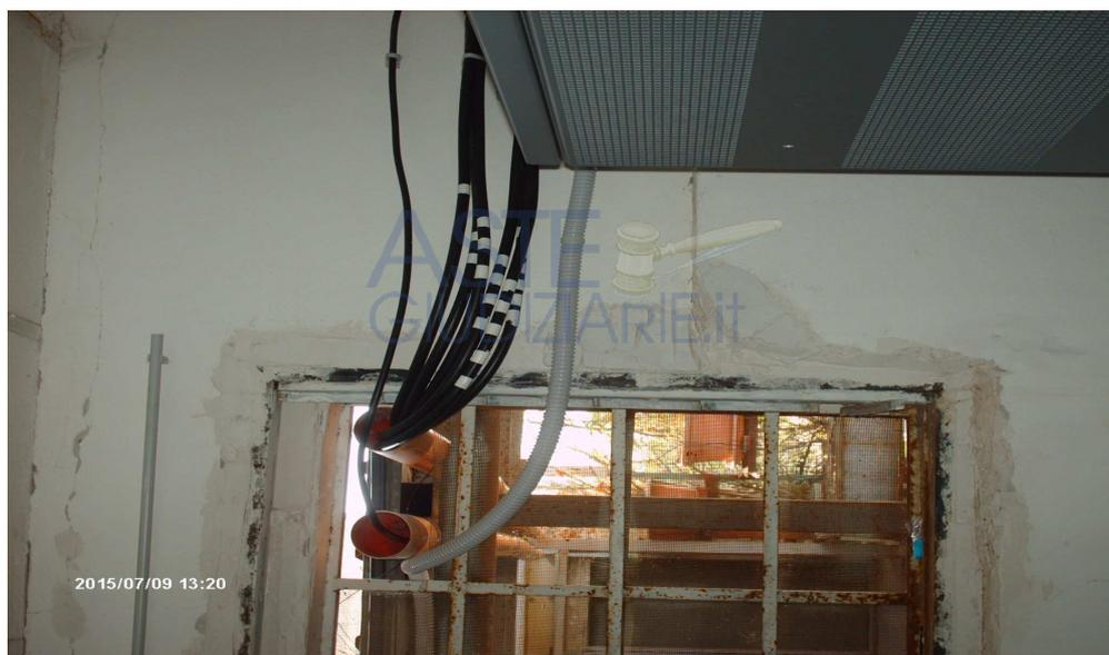
FOTO 8 - DEI CAVI DI COLLEGAMENTO TRA QUADRO DI CONTROLLO ED ANTENNE POSTE SU TORRINO ASCENSORE
