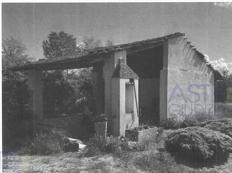
Vista della tettoia dal cortile
