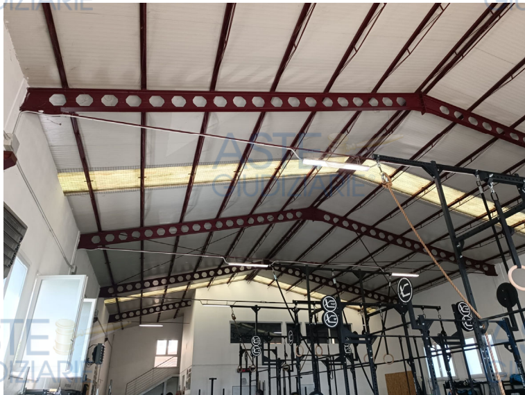
Vista interna del deposito adibito a palestra
