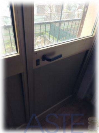
Serramento su balcone
