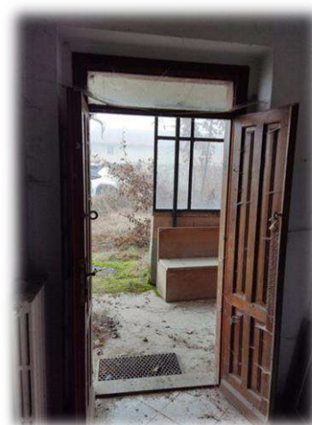
Portoncino d'ingresso all'abitazione
