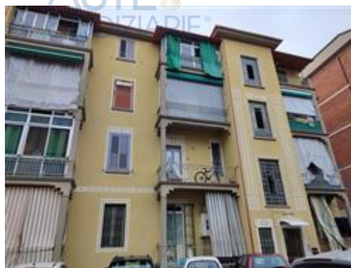
Prospetto lato cortile interno
