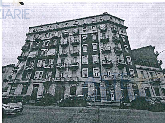
Facciata condominiale su Via Cherubini n. 3
