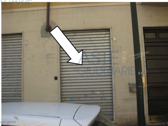
porte di accesso locale lato strada
