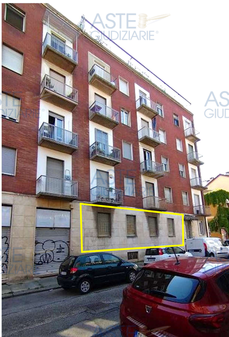
Lo stabile visto da Via Pont; con il rettangolo giallo si indicano le finestre dell'appartamento pignorato
