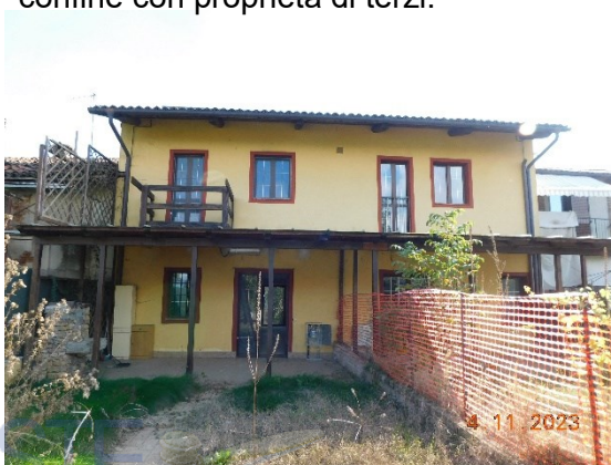
figura - vista porzione di fabbricato ad uso abitativo lato nord e area ad esso antistante
