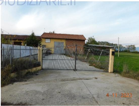
figura - vista accesso al compendio edilizio
