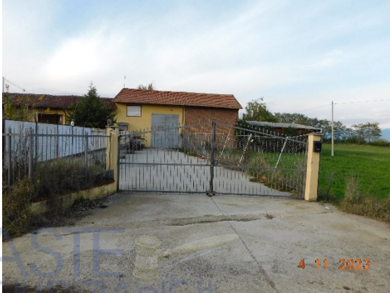
figura - vista accesso al compendio edilizio
