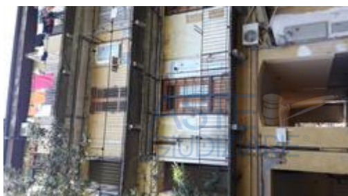
FACCIATA LATO CORTILE
