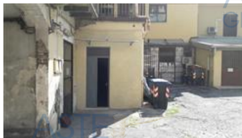
INGRESSO RETRO DA CORTILE
