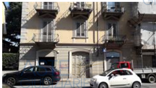
FACCIATA CORSO CASALE
