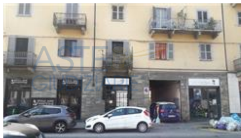
FACCIATA CORSO CASALE 104
