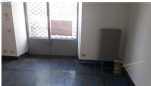
PORTA INGRESSO NEGOZIO LATO STRADA
