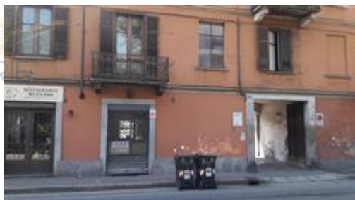
FACCIATA CORSO CASALE
