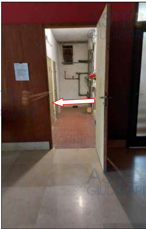
Identificazione del locale cantina
