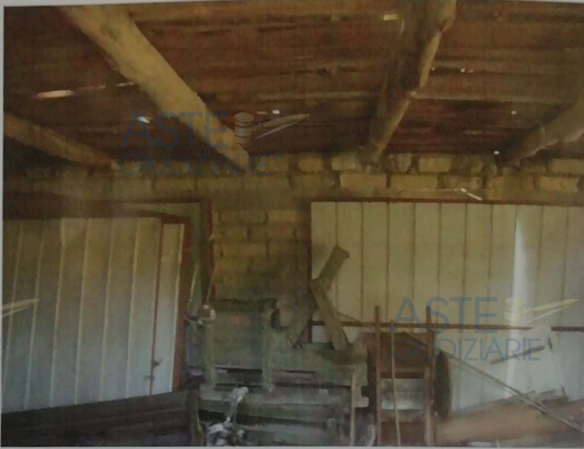
Illustrazione 7: Fabbricatino agricolo vista interna
