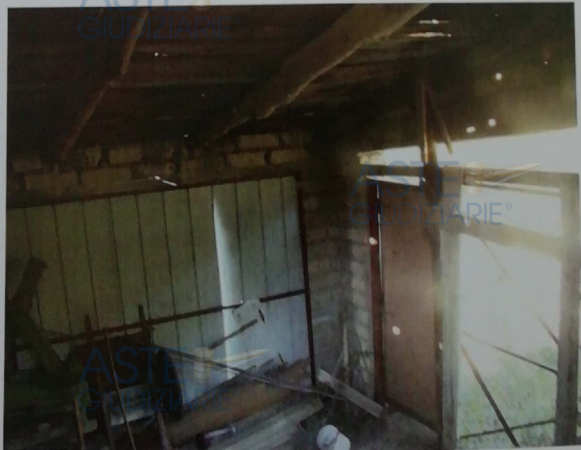
Illustrazione 6: Fabbricatino agricolo vista interna
