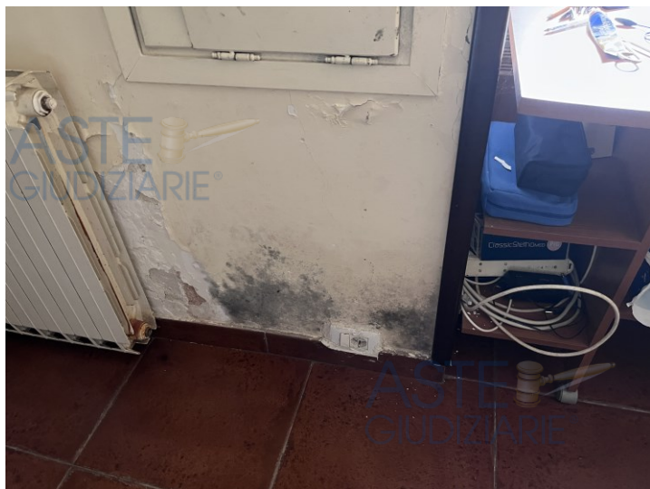
Particolari infiltrazioni/muffe
