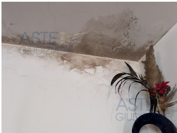
Particolari infiltrazioni/muffe
