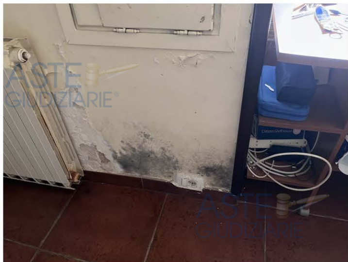
Particolari infiltrazioni/muffe
