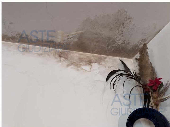
Particolari infiltrazioni/muffe
