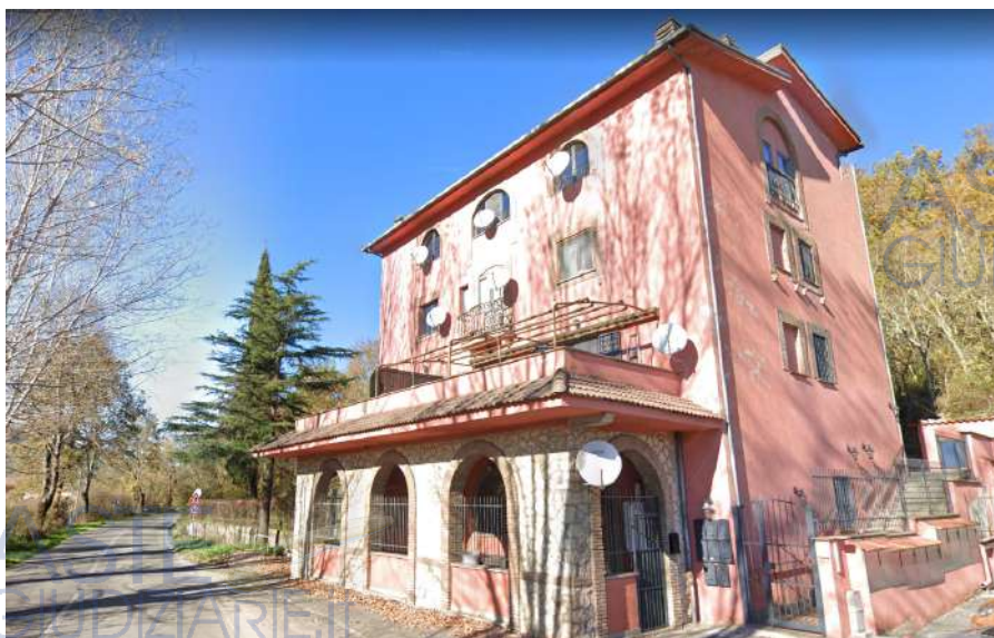
Figura 3.4: Vista dell'edificio condominiale nel quale si trova, ai piani 3° e 4°, l'appartamento oggetto del pignoramento.
