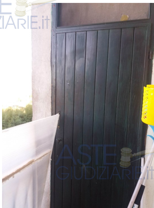
Veduta del ripostiglio esterno
