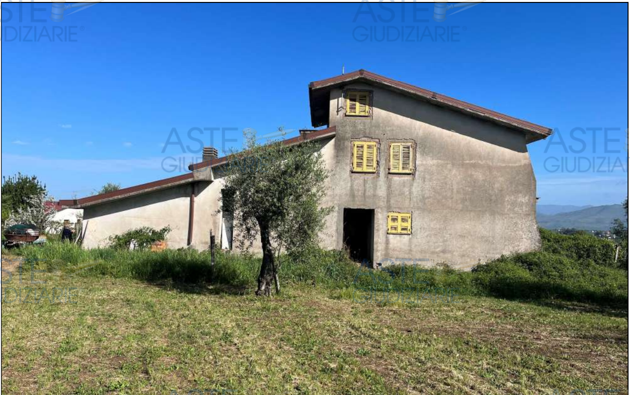
Presa fotografica edificio
