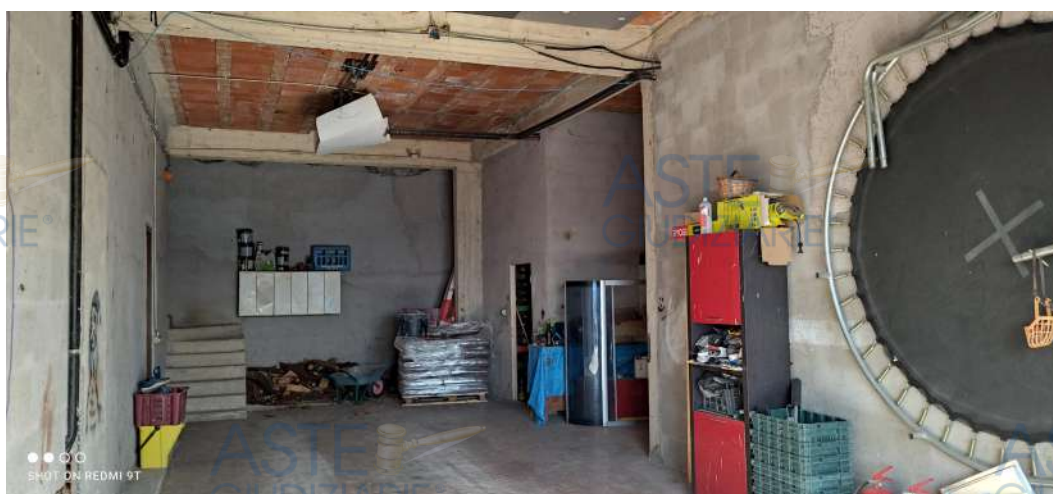
Vedute interne piano terra: sub 501 garage
