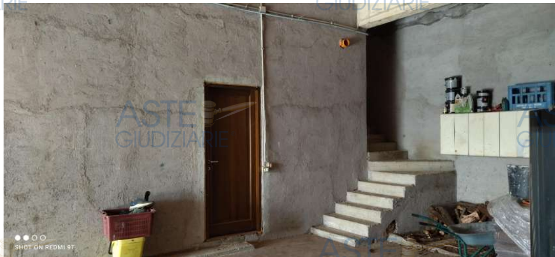
Vedute interne piano terra: sub 501 garage
