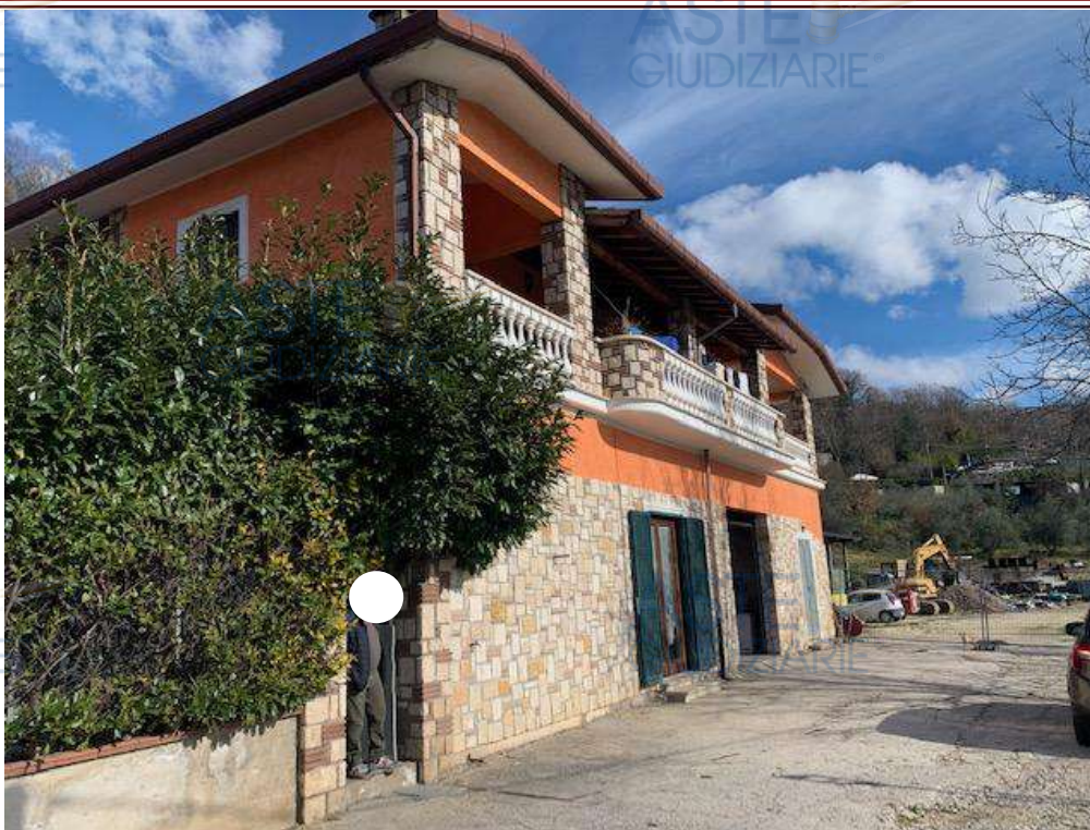
Vedute esterne: prospetto laterale destro
