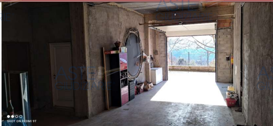
Vedute interne piano terra: sub 501 garage
