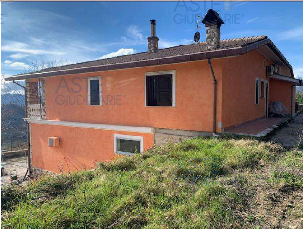
Vedute esterne: prospetto posteriore
