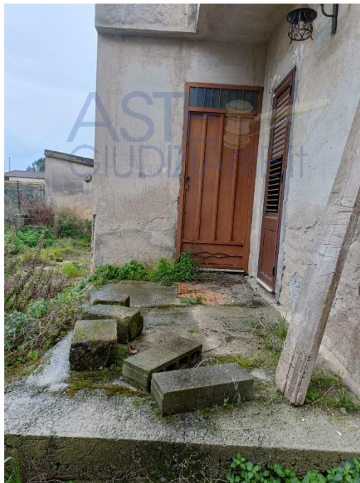
Foto 9. Porta di ingresso alla scala che conduce al piano primo e al lastrico solare
