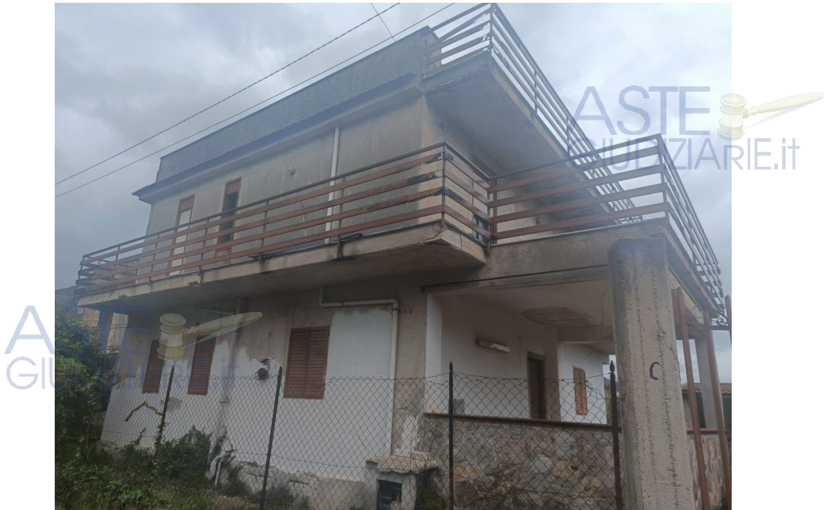
Foto 1-2. Viste esterne del fabbricato.
