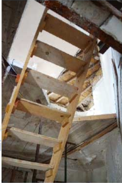
visuale dal vano scala
