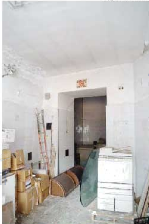
vano di accesso
