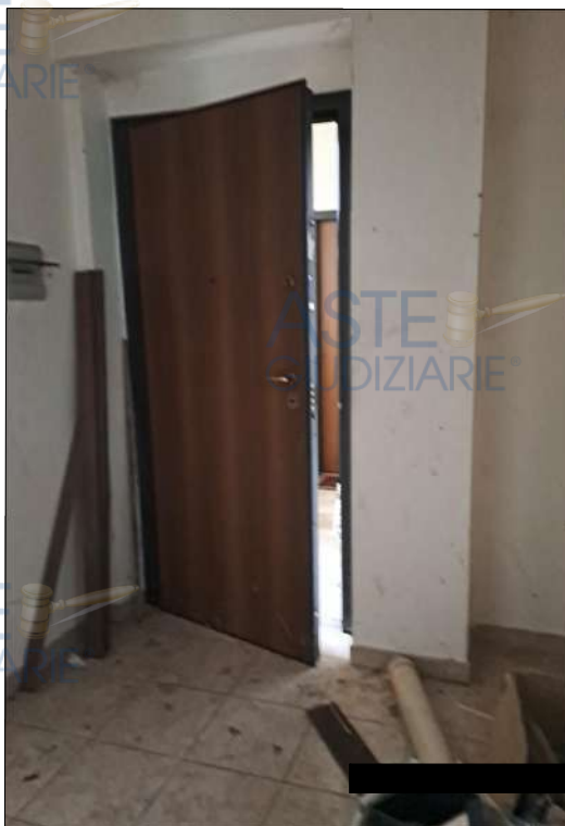
Porta ingresso appartamento
