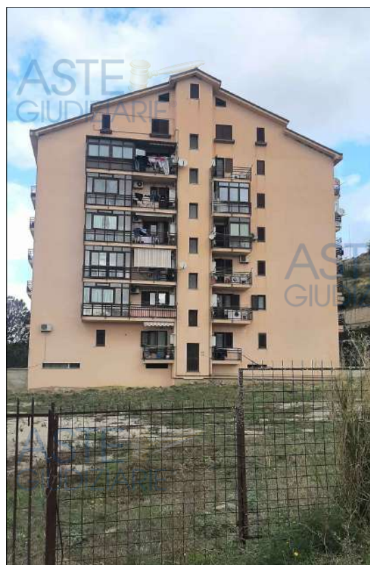
Prospetto retrostante - edificio C
