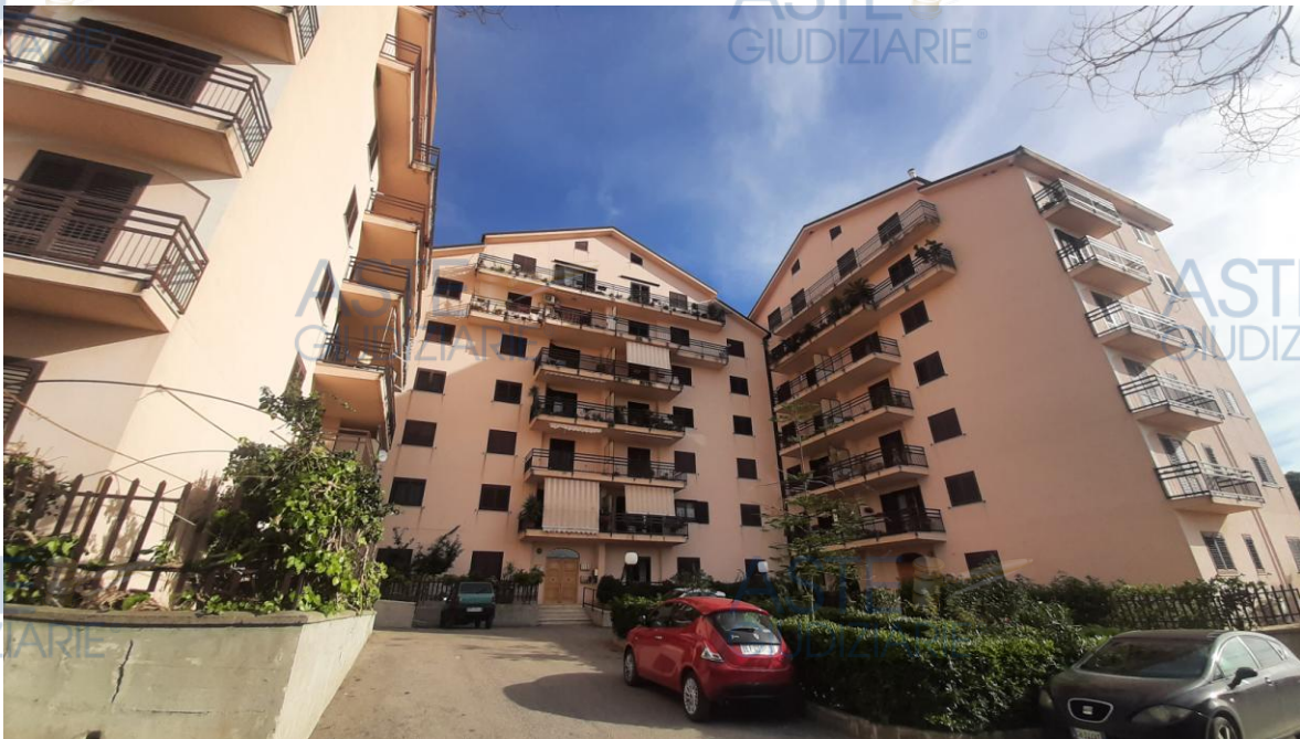
Foto complesso degli edifici
