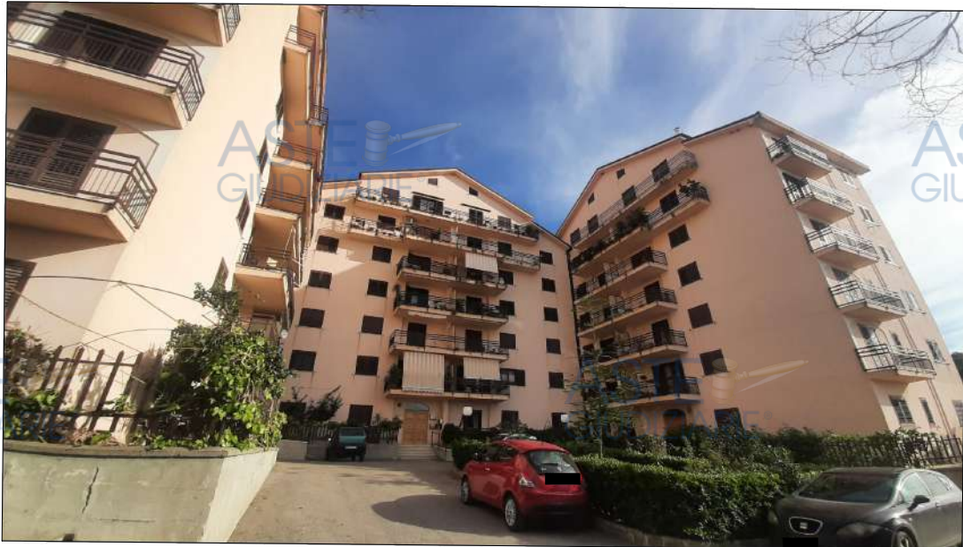
Prospetto - complesso dei tre edifici
