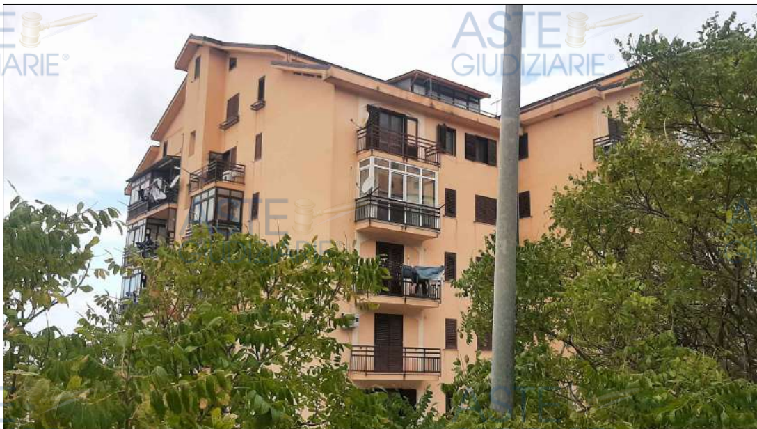
Prospetto laterale edificio
