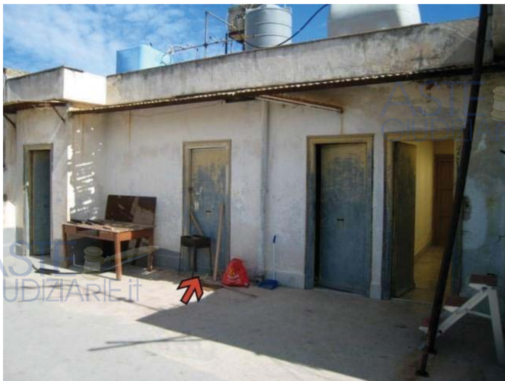
Foto n. 18. Il vano lavanderia ubicato al piano quinto lato sinistro seconda porta a destra.
