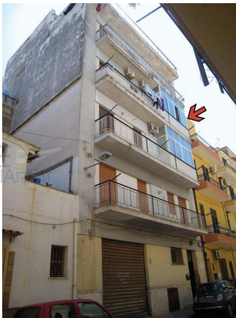
Foto n. 2. Altra visione dell'edificio. la freccia rossa indica il box realizzato abusivamente.
