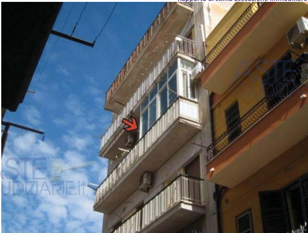
Foto n. 22 Il box prospiciente la via Gumina, realizzato abusivamente.
