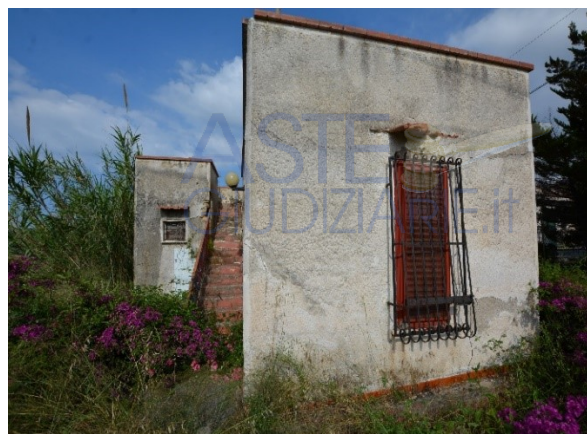
Foto 4 - Prospetto Ovest con scala per il lastrico solare
