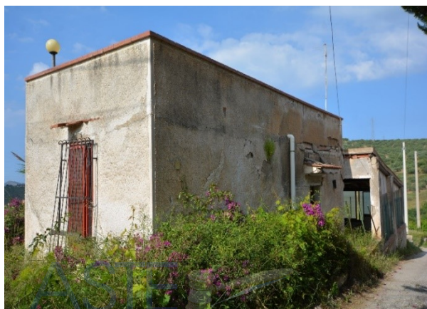
Foto 3 - Prospetti Ovest e Sud
