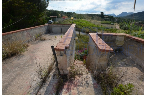
Foto 15 - Lastrico solare di 1° piano
