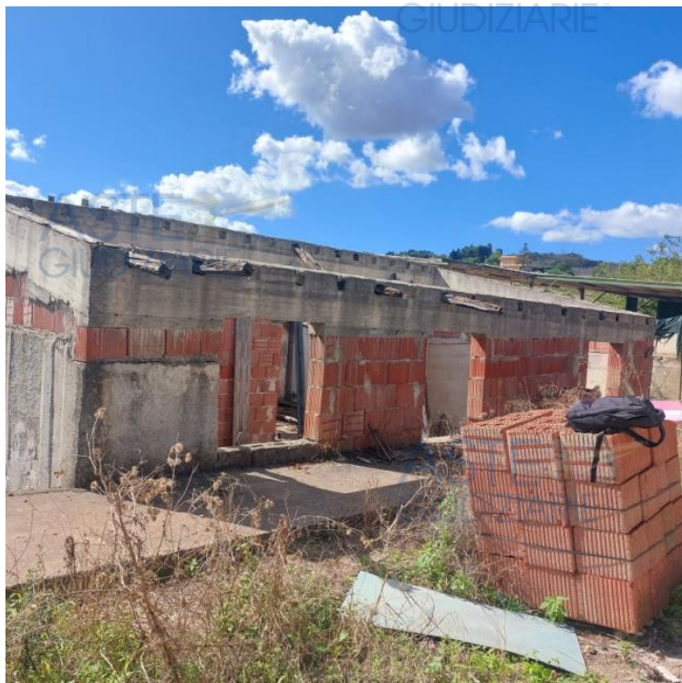
Foto Prospetto Nord-Est
