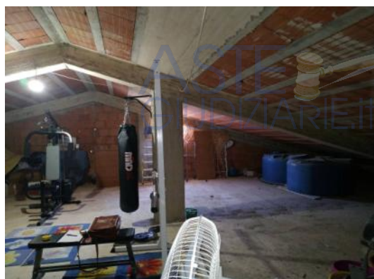
In corso di costruzione
