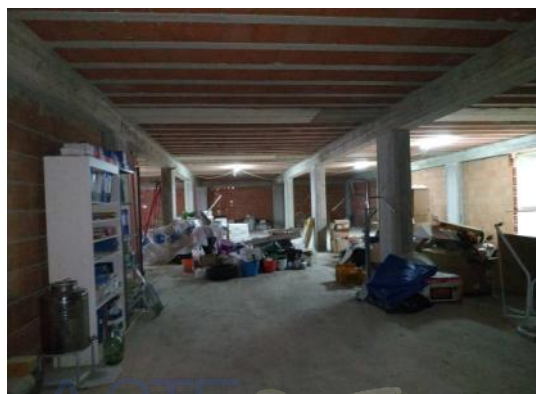
In corso di costruzione
