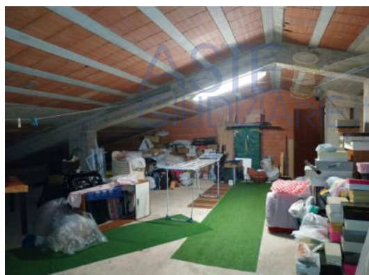
In corso di costruzione
