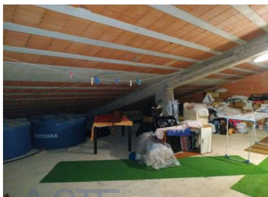
In corso di costruzione
