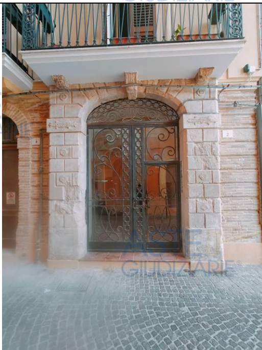
Ingresso condominiale da via Getulio n. 2
