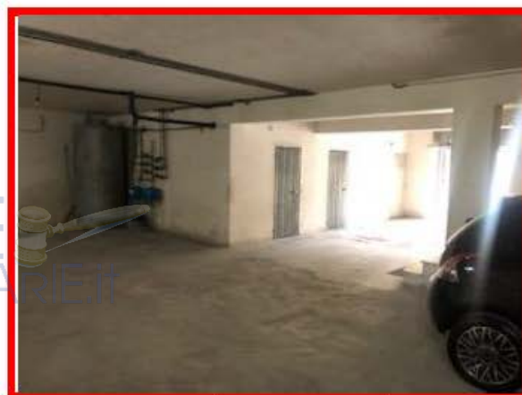
Foto 4 - Autorimessa zona di accesso.
