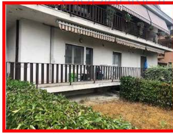
Foto 2 - Appartamento lato strada.
