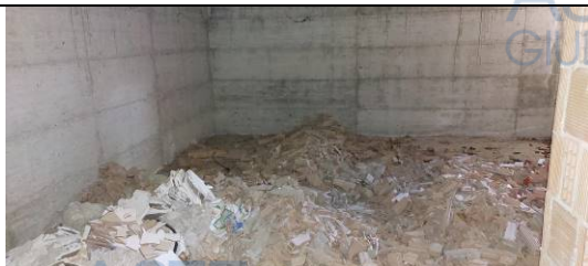
Vista del piano cantinato
