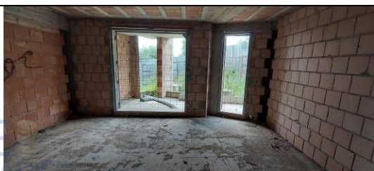
Vista del piano terra
