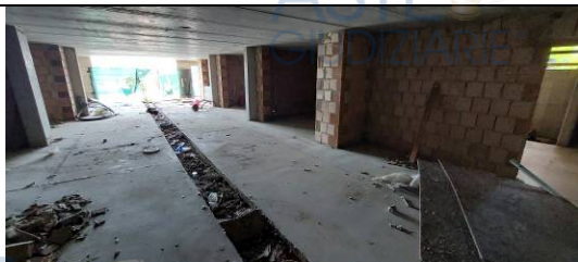
Vista del piano cantinato
