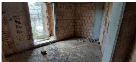
Vista del piano terra
