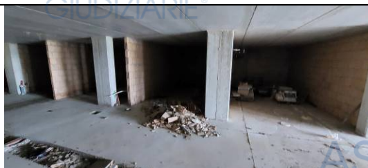
Vista del piano cantinato
