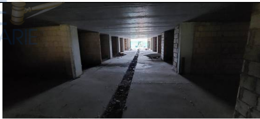
Vista del piano cantinato
