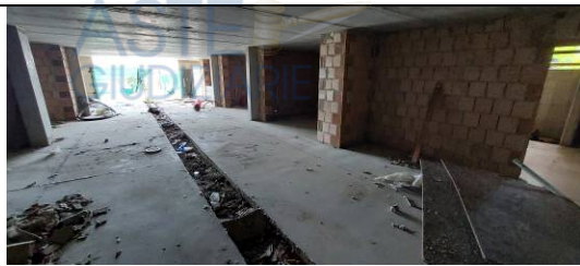
Vista del piano cantinato
