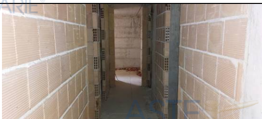
Vista del piano cantinato
