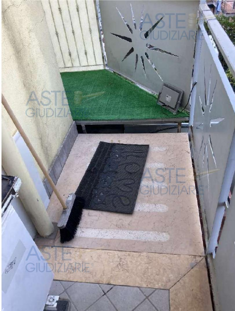
*Foto di dettaglio della pavimentazione del balcone in corrispondenza della parte aggiunta, è palese il fatto che ad un nucleo originario, nell'angolo, si sia disposta una aggiunta (cui corrisponde cambio di pavimentazione + gradino).*
