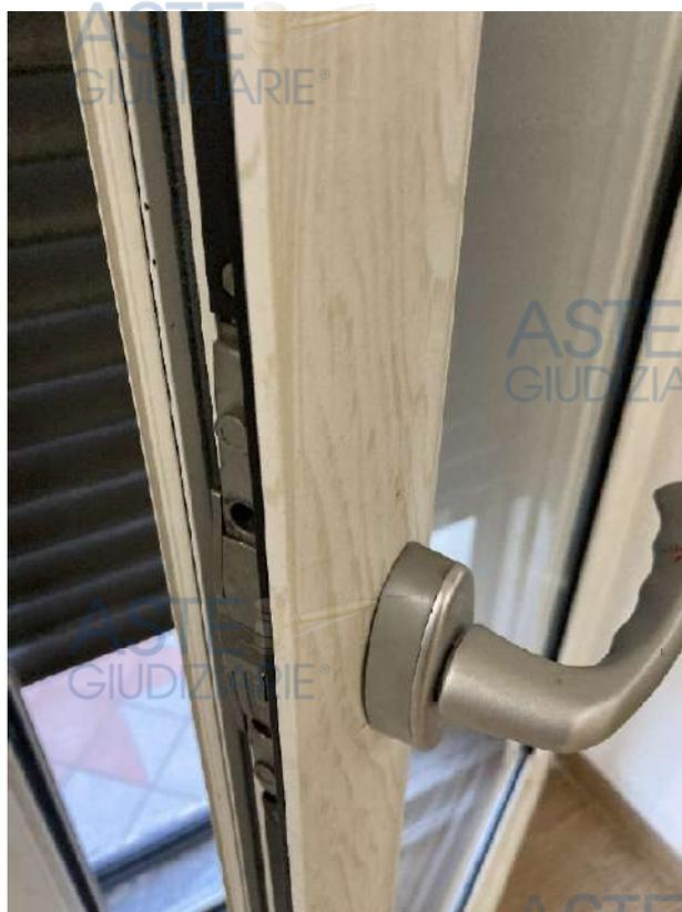
*Foto riguardanti infissi esterni presenti nell'immobile in alluminio con taglio termico, vetro camera, dotati di cassonetto per avvolgibile e zanzariere.*
