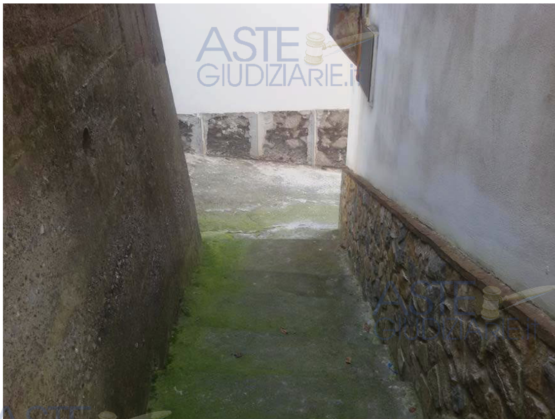
Passaggio pedonale p.lla 220 con, in fondo, l'intersezione con Via Casa De Rosa II
