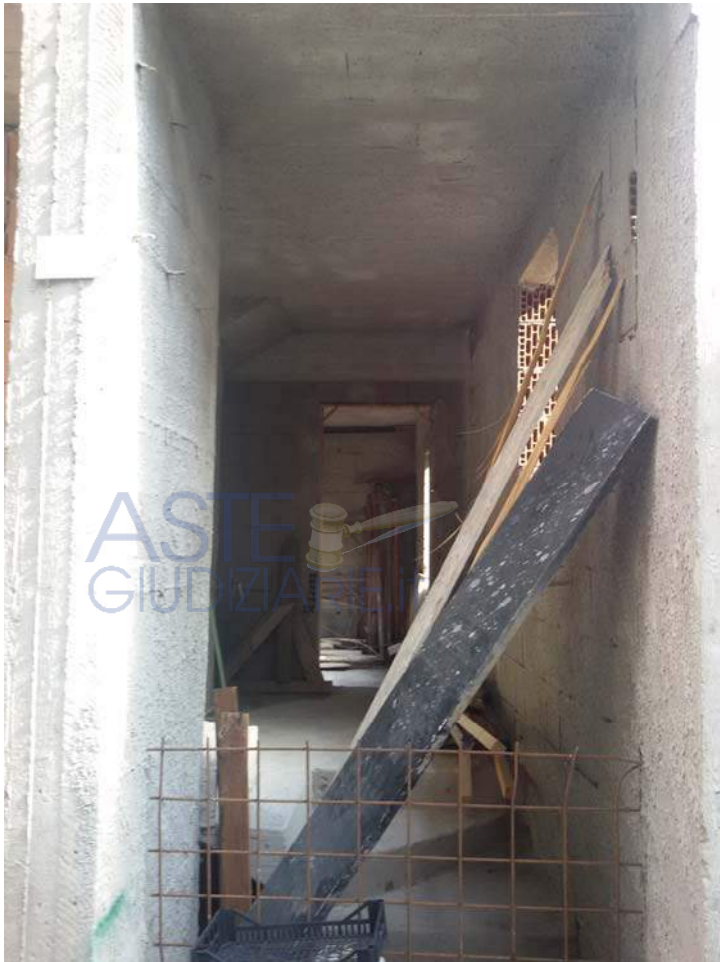
Vista d'insieme del locale 2
