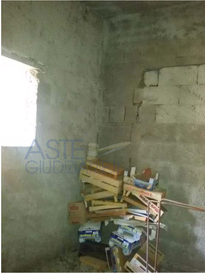
Vista d'insieme del Locale 4
