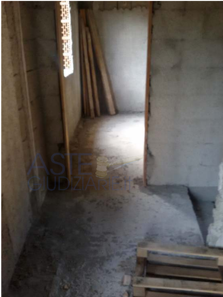
Vista d'insieme del Locale 7
