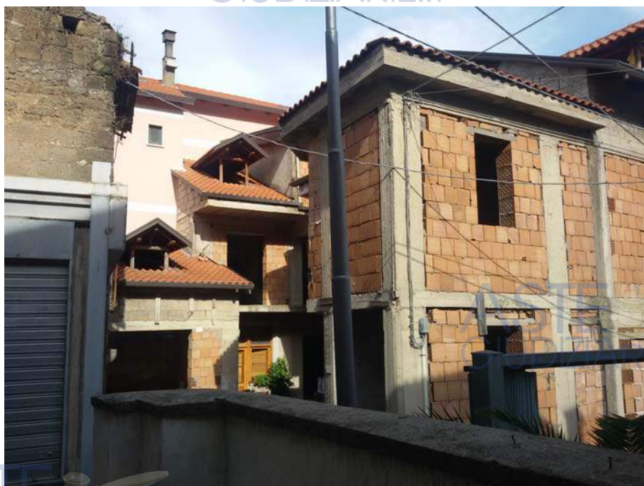
Vista d'insieme dell'edificato
