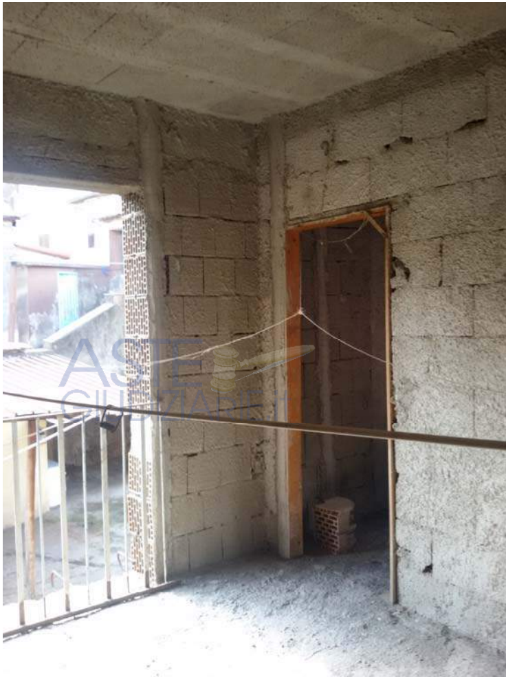
Vista d'insieme del Locale 9
