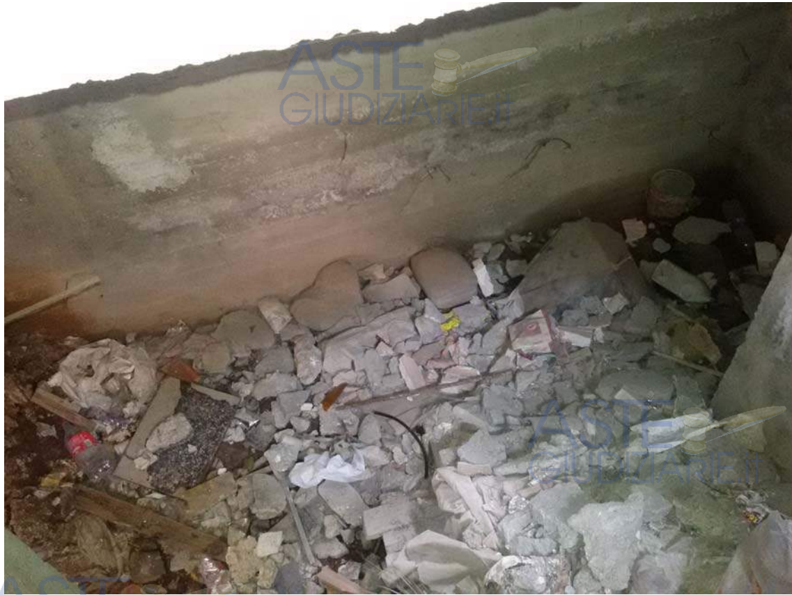
Vista d'insieme del Locale 1
