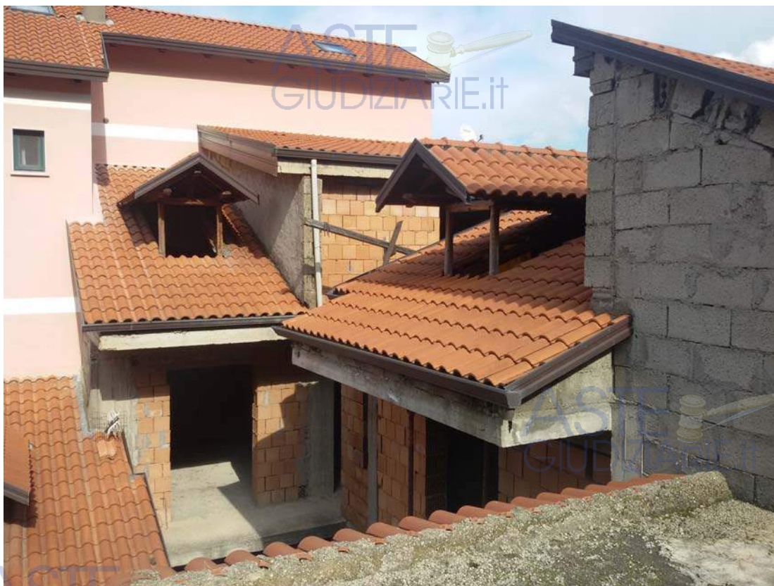
Vista esterna dei sottotetti
