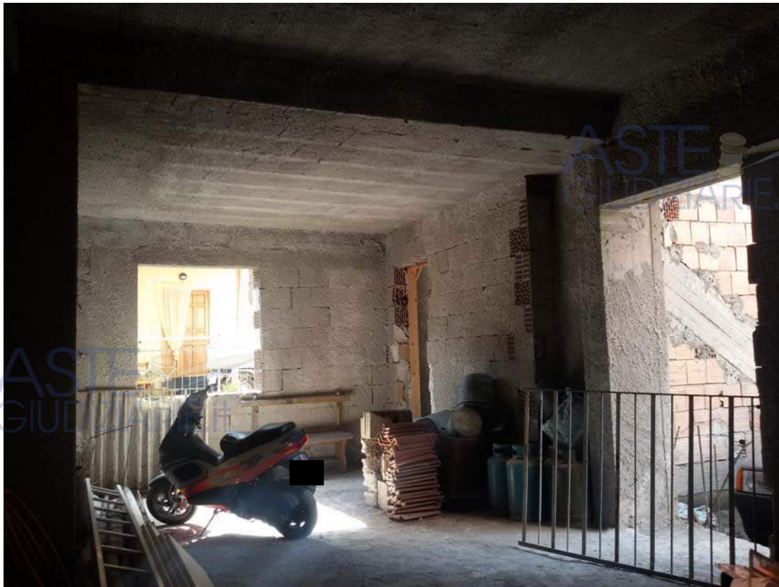
Vista d'insieme del Locale 3
