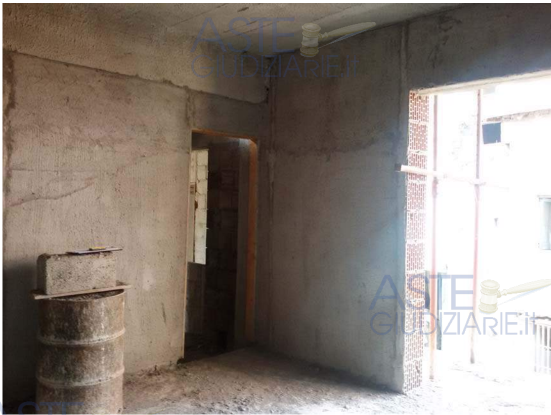
Vista d'insieme del Locale 10
