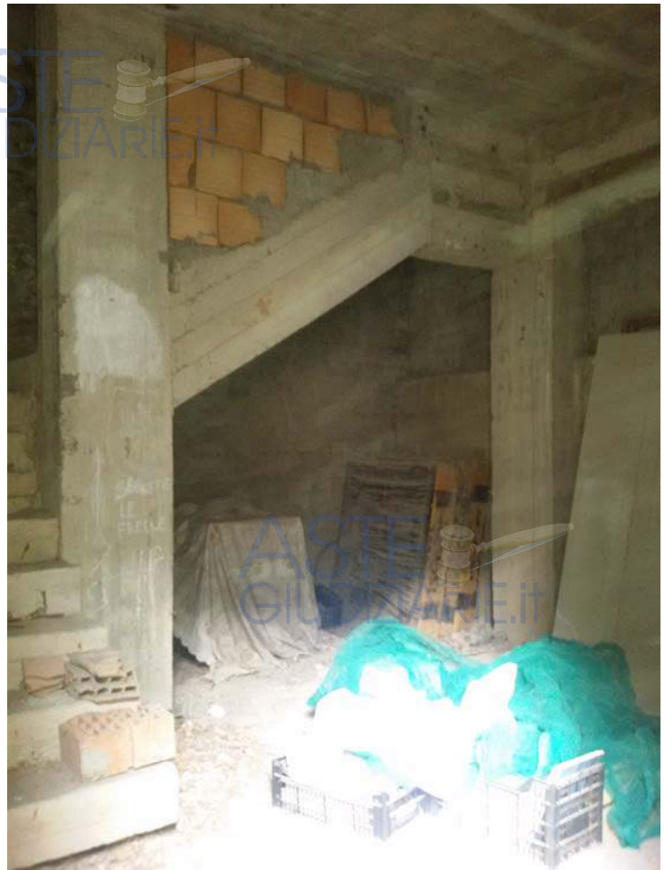
Vista d'insieme del Locale 5
