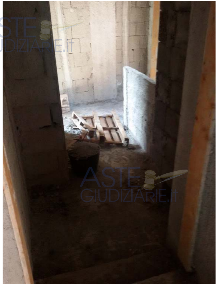
Vista d'insieme del Locale 8
