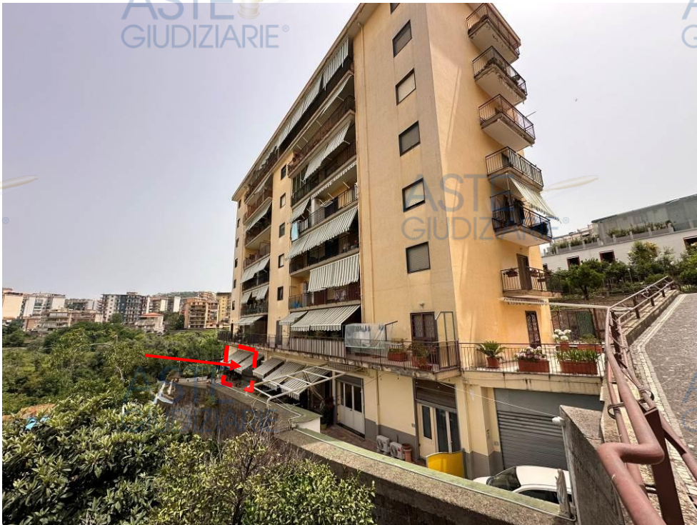
Vista dal cortile interno lato nord con individuazione dell'u.i.
