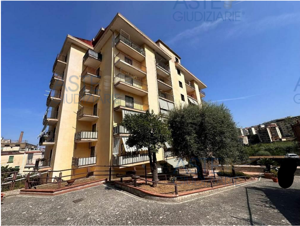
Scala C Vista dal cortile interno lato sud
