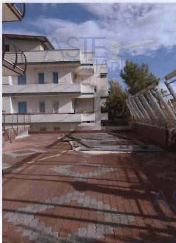
Foto 10: Area pertinenziale a confine con il ristorante
