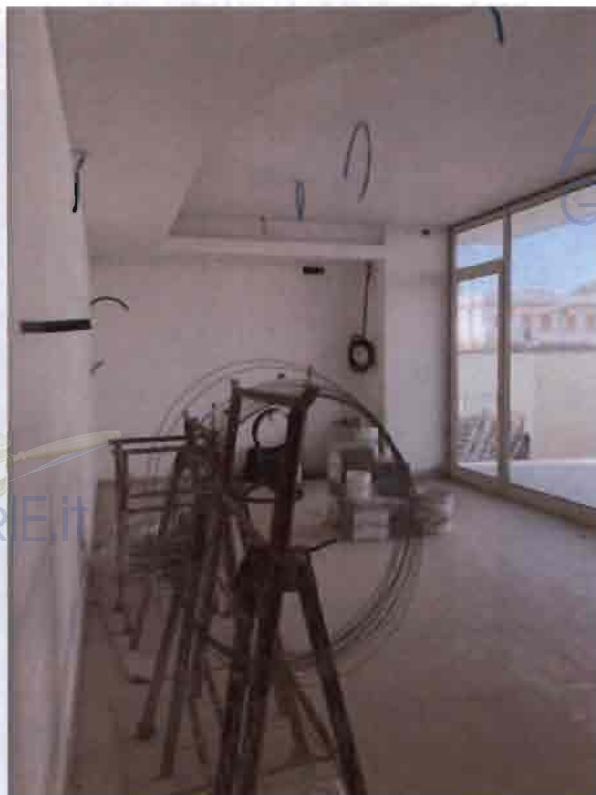
Foto 5: Lato bar piano rialzato
