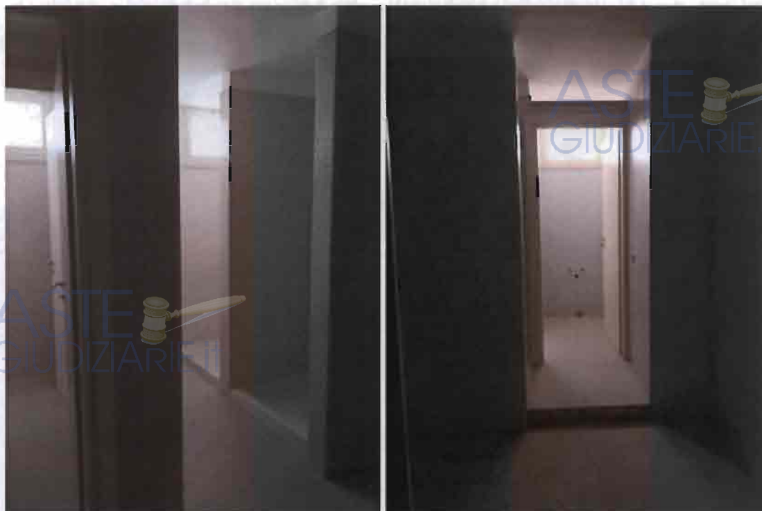
Foto 11: Bagni piano seminterrato
