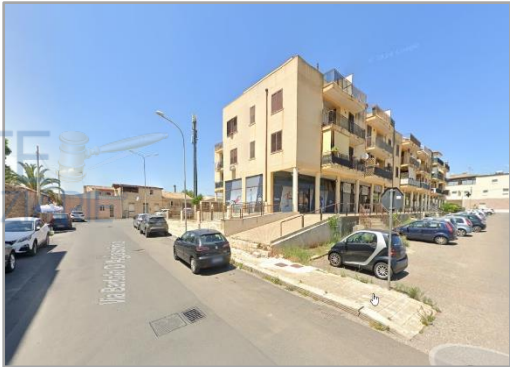
Foto dell'edificio da Via Bartolo d'Agostino
