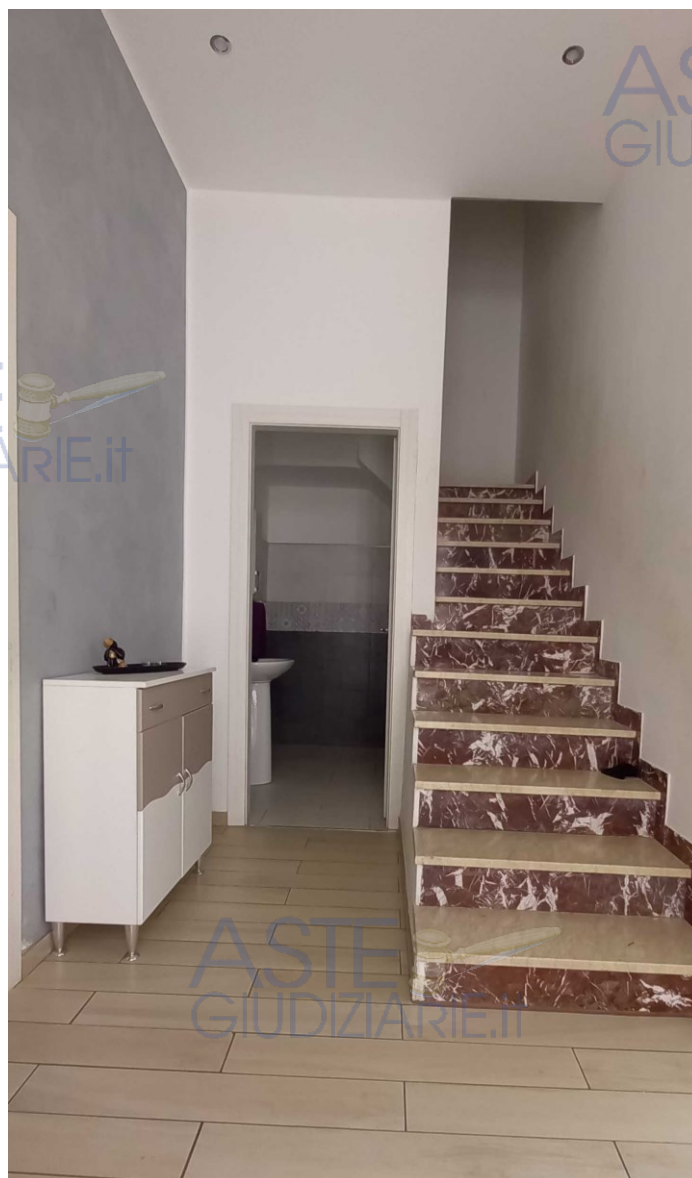
Foto 5 – Immobile “1A” – Ingresso vanoscala
