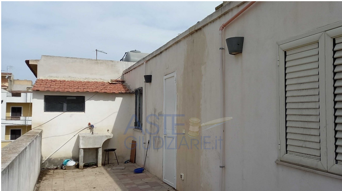
Foto 15 – Immobile “1A” – Terrazza al II P
