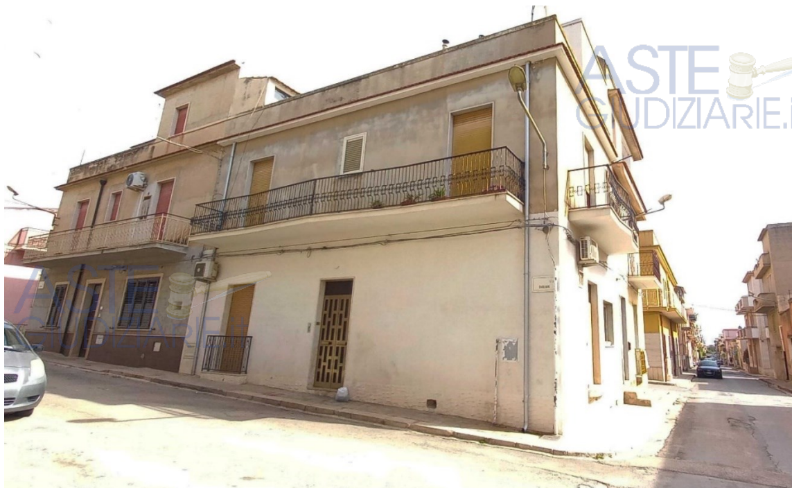
Foto 4 – Immobile “1A” – Veduta prospettica del fabbricato
