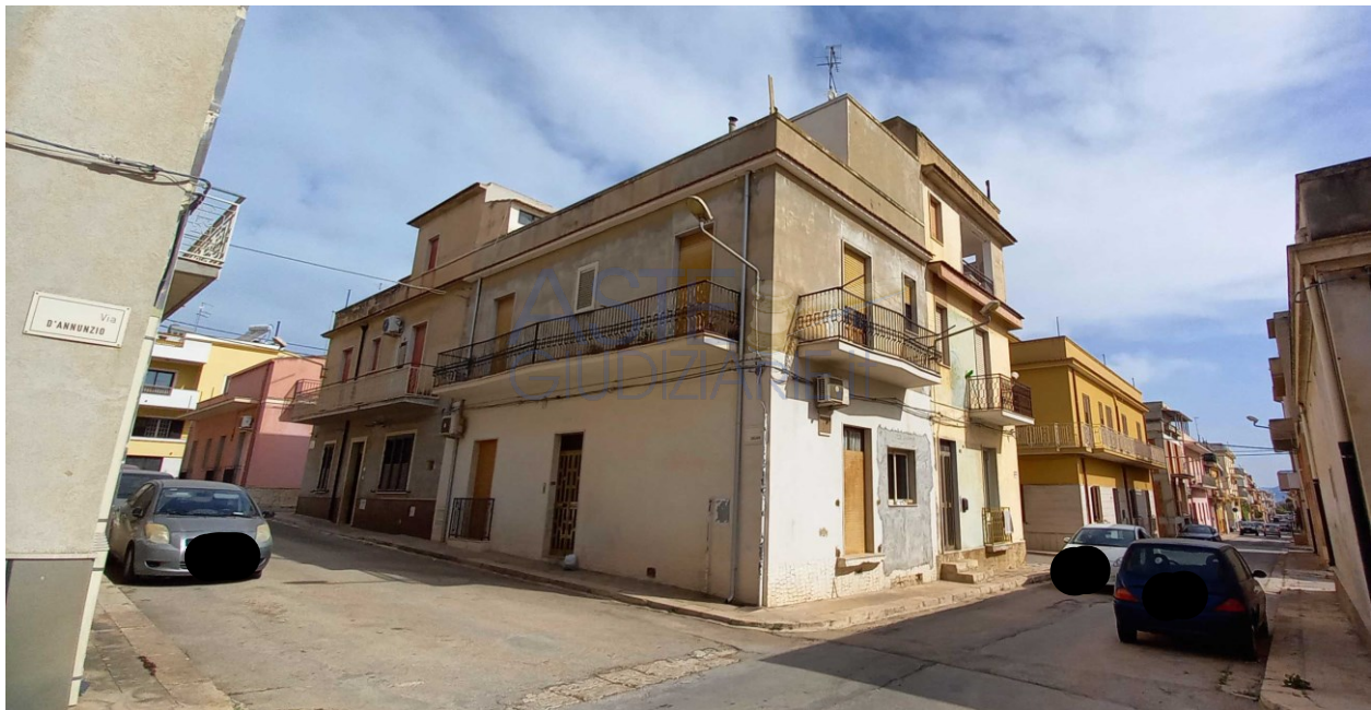
Foto 1 – Immobile “1A” – Fabbricato ad angolo tra via Cagliari e via D'Annunzio
