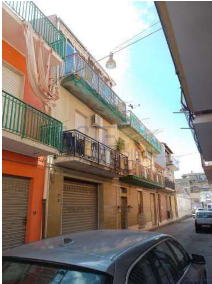
Foto 1 – Immobile “1A” – Prospetto principale visto da Sud
