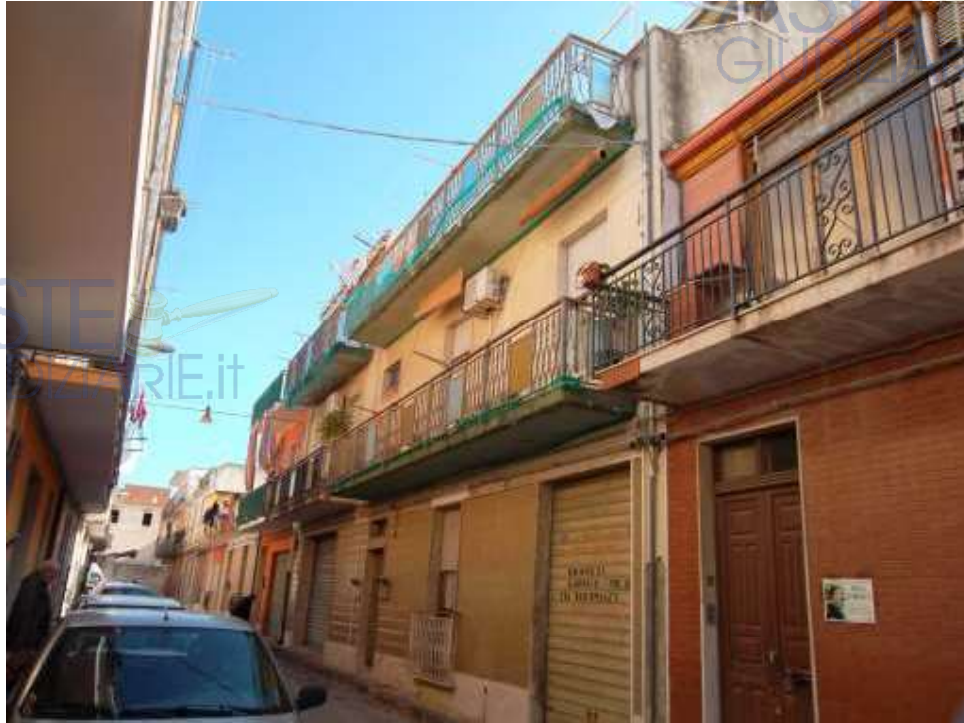
Foto 2 – Immobile “1A” – Prospetto principale visto da Nord
