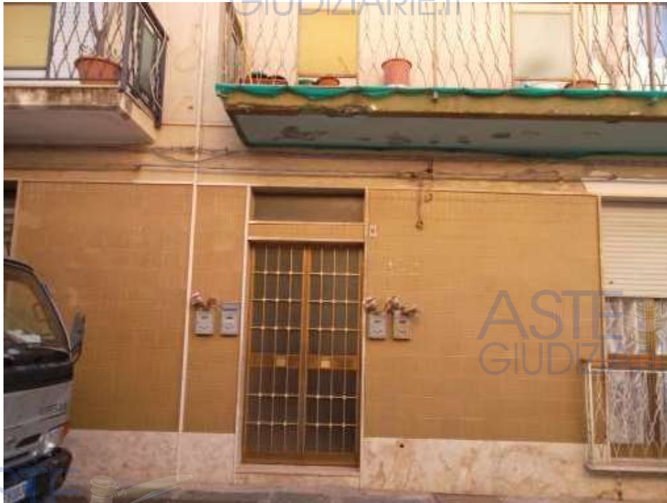
Foto 3 – Immobile “1A” – Ingresso al fabbricato
