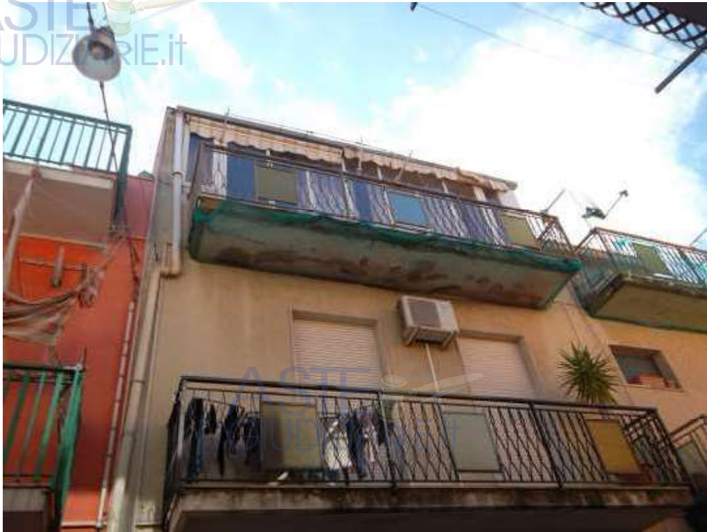
Foto 4 – Immobile "1A" – Balcone e chiusura terrazza lato Sud
