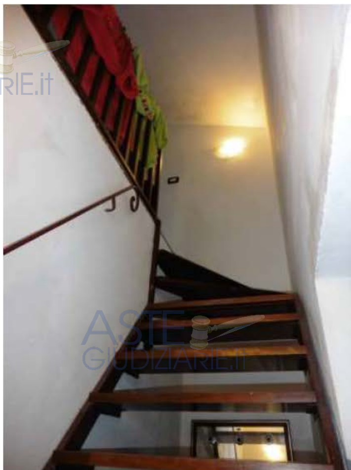
Foto 5 – Appartamento 6A – Scala interna all'appartamento
