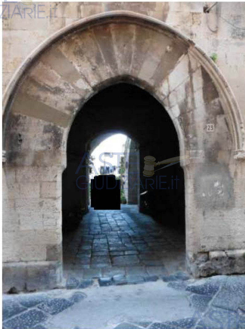
Foto 1 – Deposito "3A" – Ingresso al cortile interno, dal quale si accede all'immobile in oggetto
