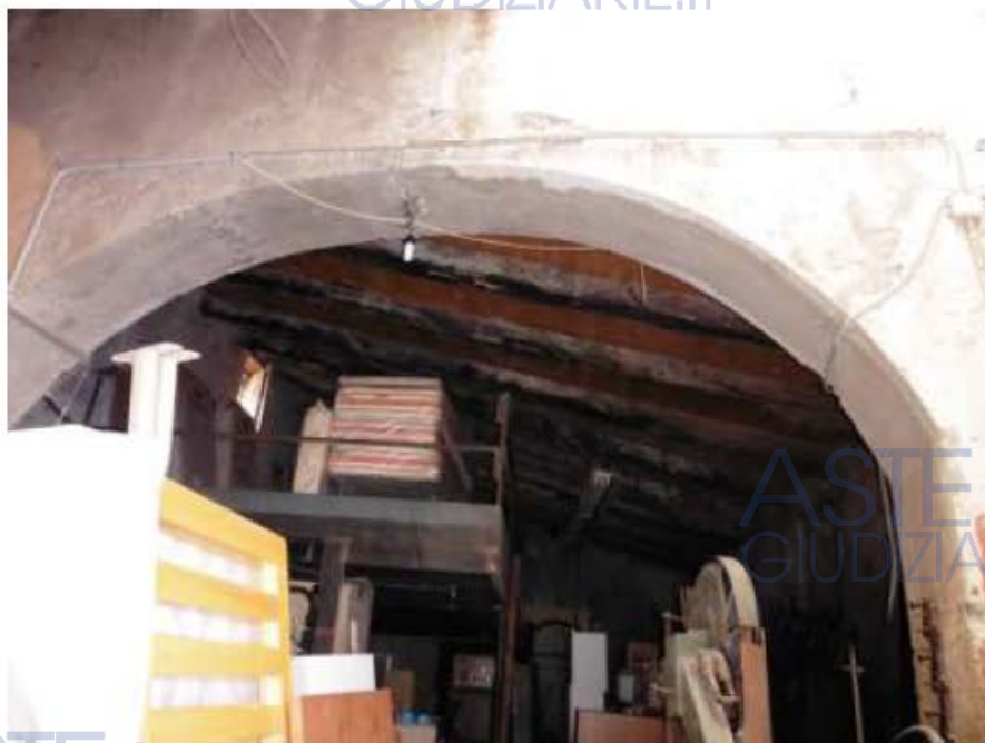
Foto 7 – Deposito 3A – Interno
