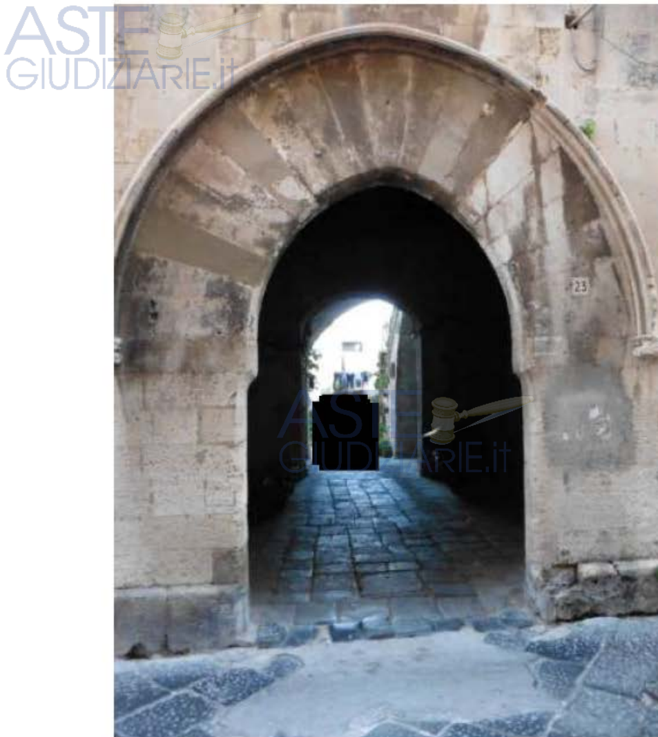
Foto 1 – Appartamento "4A" – Ingresso al cortile interno, dal quale si accede all'immobile in oggetto
