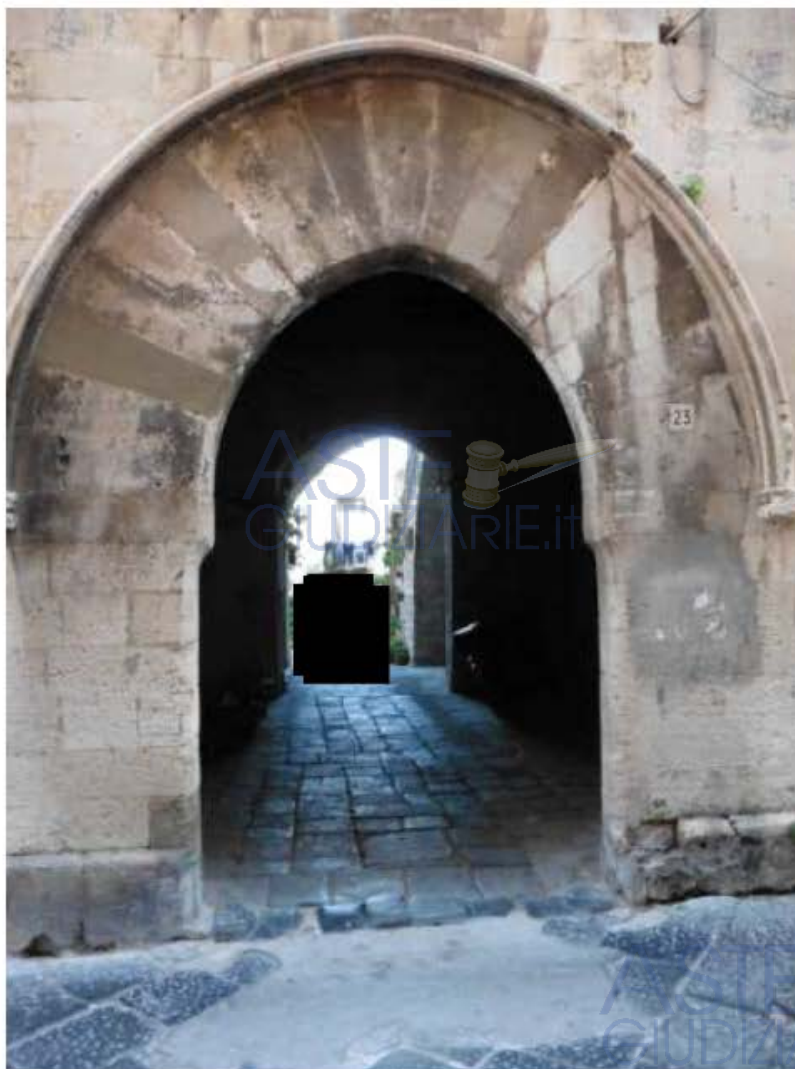
Foto 1 – Appartamento "6A" – Ingresso al cortile interno, dal quale si accede all'immobile in oggetto
