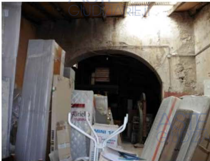
Foto 5 – Deposito 3A – Interno
