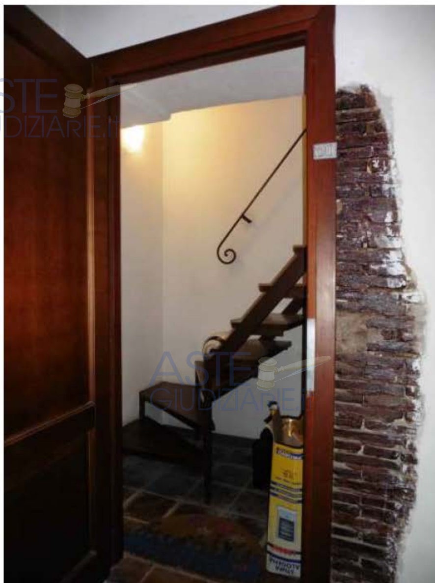
Foto 4 – Appartamento “6A” – Ingresso dell’unità immobiliare in oggetto
