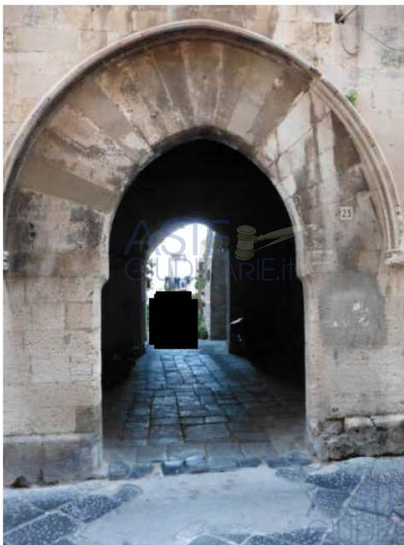
Foto 1 – Appartamento "7A" – Ingresso al cortile interno, dal quale si accede all'immobile in oggetto
