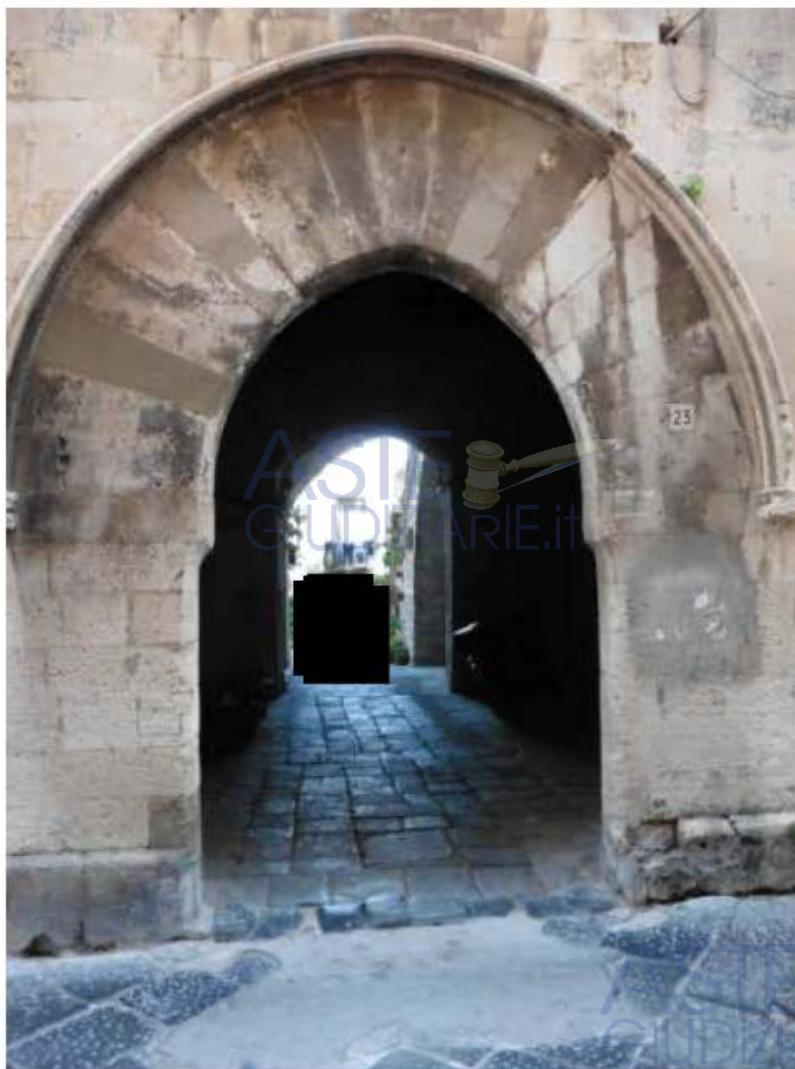
Foto 1 – Appartamento "5A" – Ingresso al cortile interno, dal quale si accede all'immobile in oggetto
