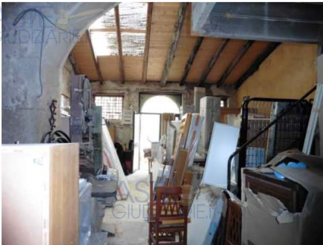
Foto 8 – Deposito 3A – Interno
