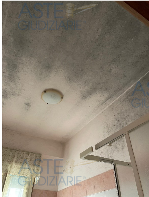
Degrado fisico-materico delle pareti della cucina e del solaio del bagno
