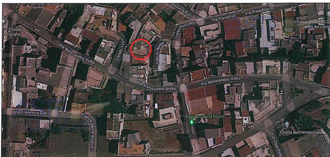
Foto 1 - Vista dall'alto tratta da Google Earth Pro con cerchiato l'edificio oggetto di stima, sito nel centro storico del comune di Lentini nel Cortile Atene nn. 14-15. In zona sono presenti abitazioni con due o più elevazioni fuori terra, alcune di esse con cortile comune.
