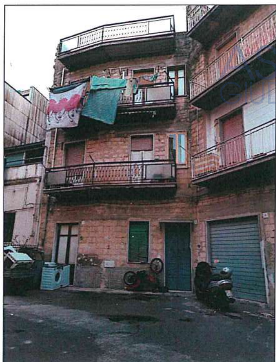
Foto 2-3 - Prospetto su Cortile Atene con ingresso dai numeri civici 14-15. L'immobile è composto da piano terra, primo, secondo e terzo piano. La facciata non è rivestita e i ballatoi necessitano di lavori di manutenzione.
