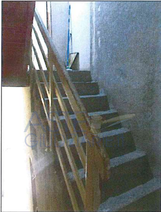
foto 8-9 - Scala che collega piano terra e primo piano; essa non è rifinita e presenta ringhiera in legno non rispettante i parametri di sicurezza. Dalla scala si accede al soggiorno, ambiente rifinito.
