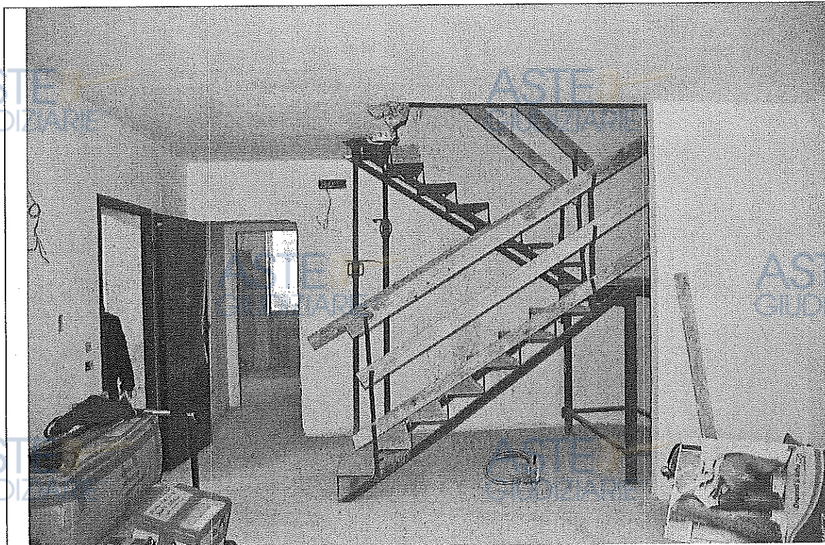
Foto n. 44 – Vista interna dell'appartamento
