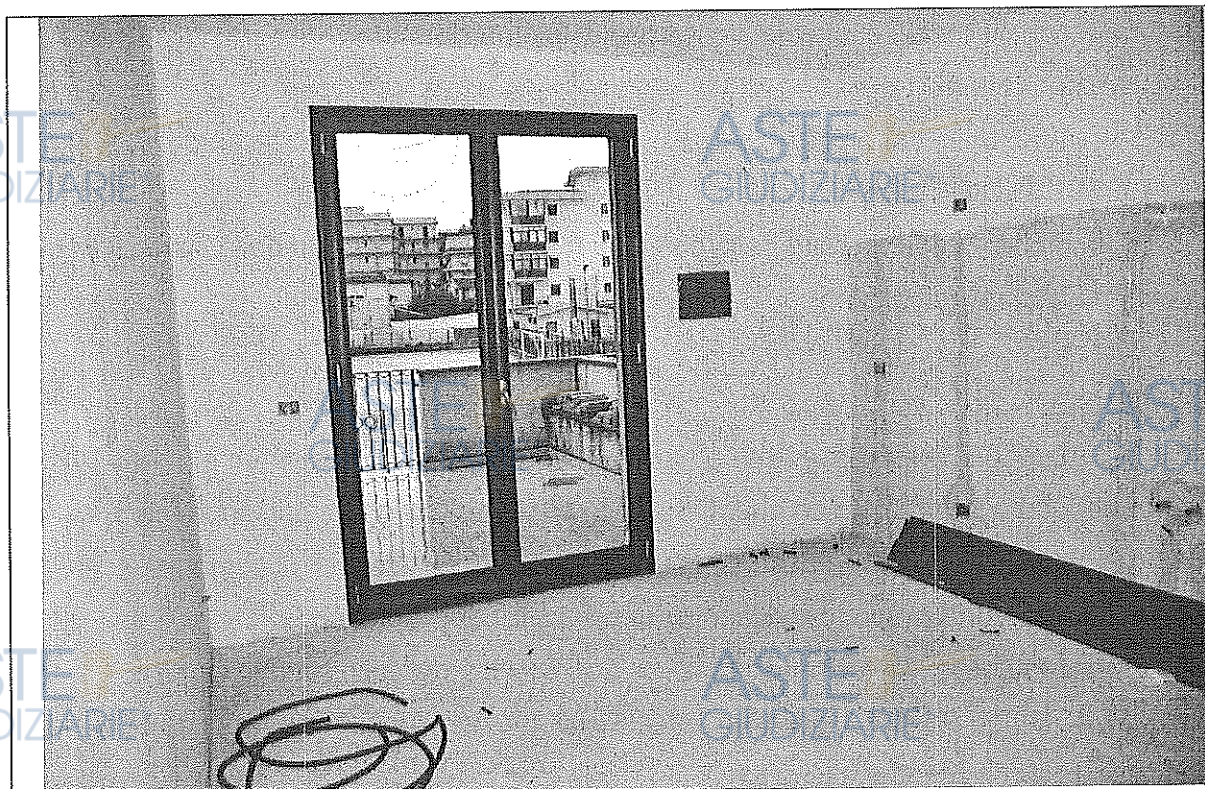
Foto n. 38 – Vano cucina ancora allo stato grezzo
