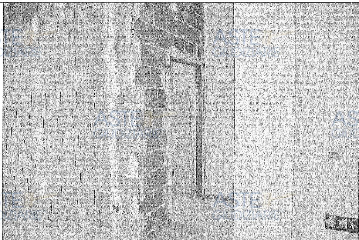
Foto n. 28 - Vista dell'immobile al piano terra sub 3
