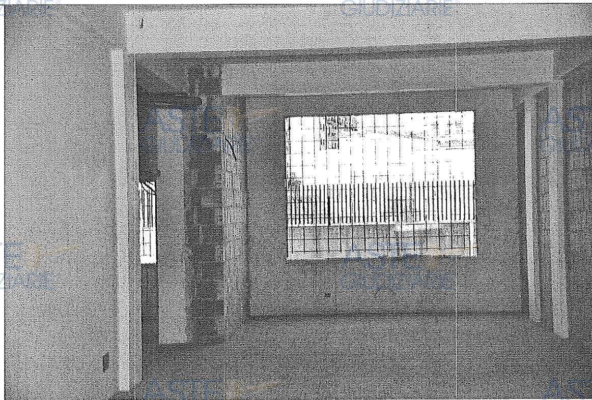
Foto n. 25 – Vista dell’immobile al piano terra sub 2
