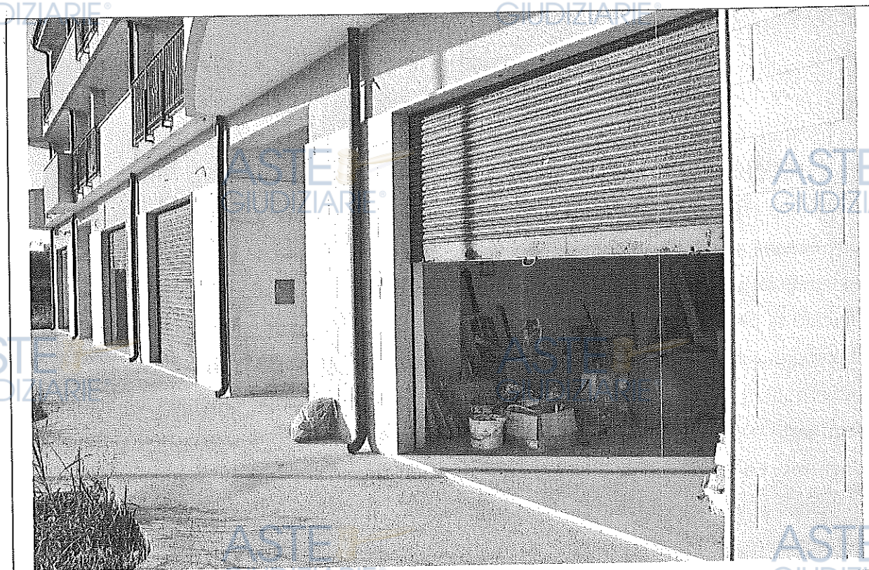
Foto n. 29 – Porta di ingresso dell'immobile al piano terra sub 4
