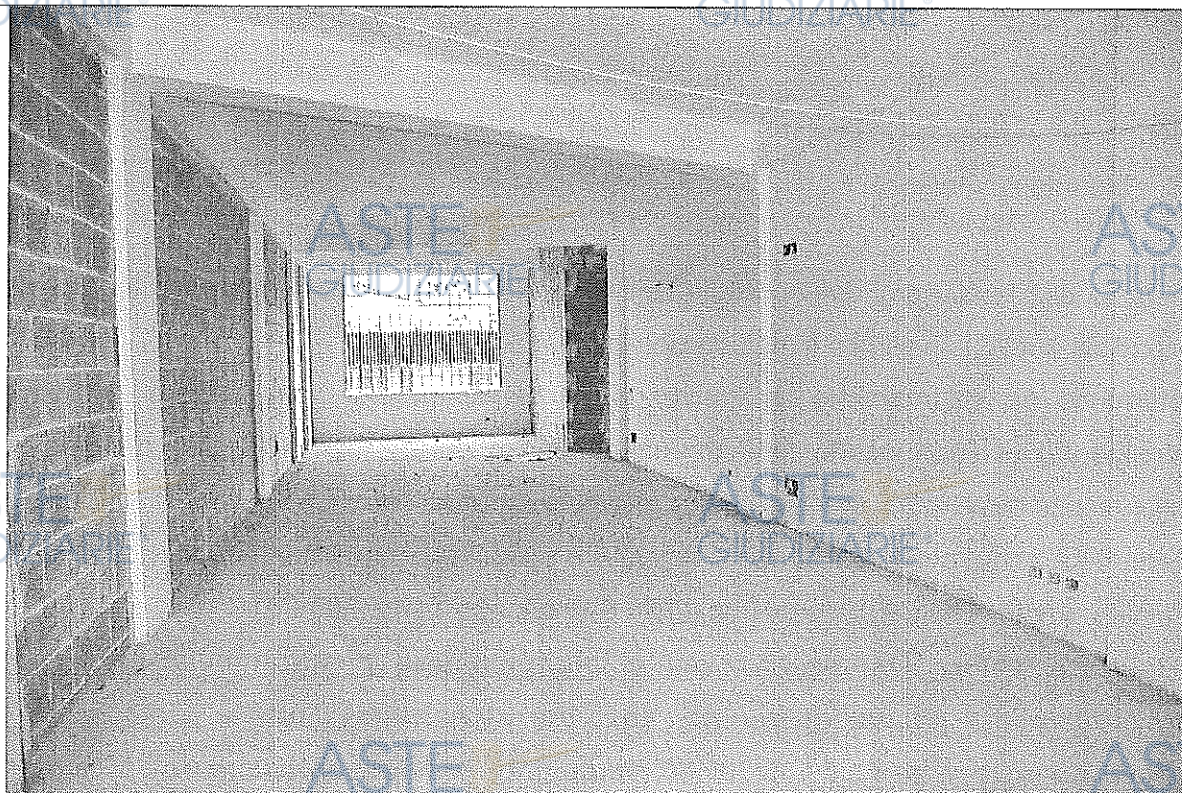
Foto n. 27 - Vista dell'immobile al piano terra sub 3
