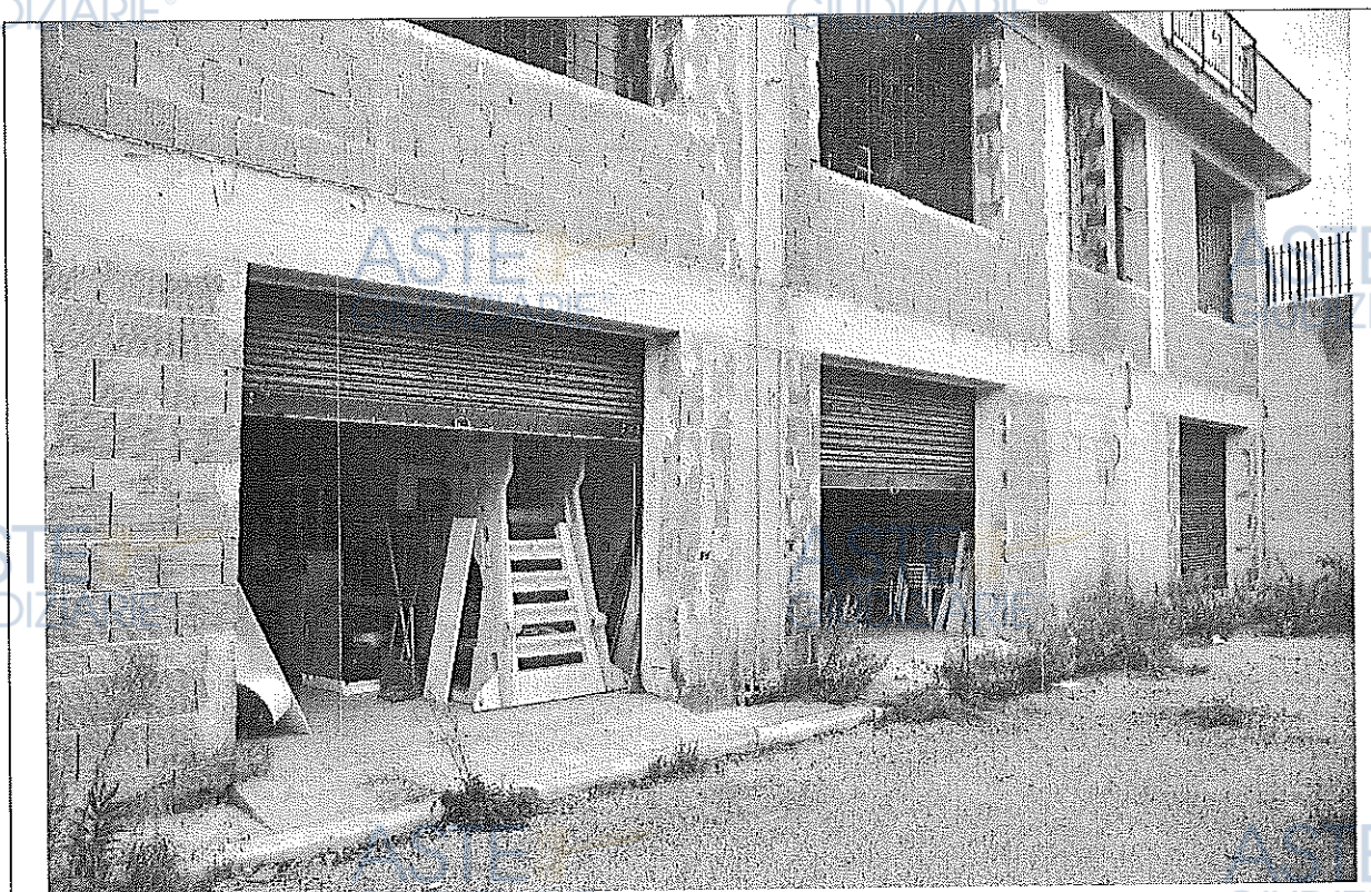
Foto n. 11 – Rampa secondaria di accesso al garage
