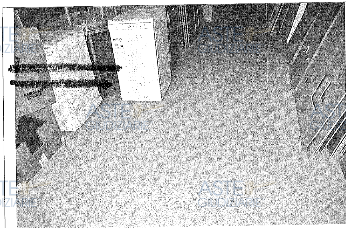
Foto n. 8 – Garage sub 17, particolare della pavimentazione
