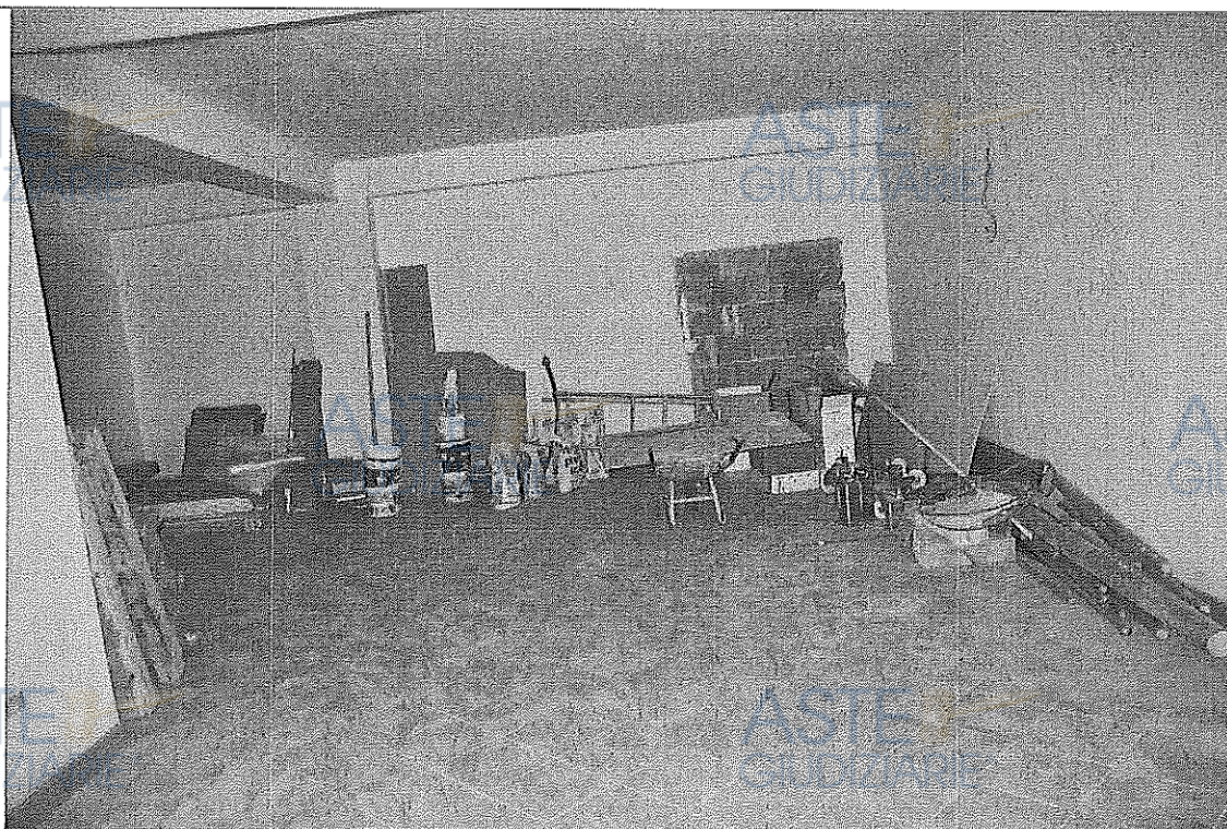
Foto n. 18 – Vista interna del garage sub 23
